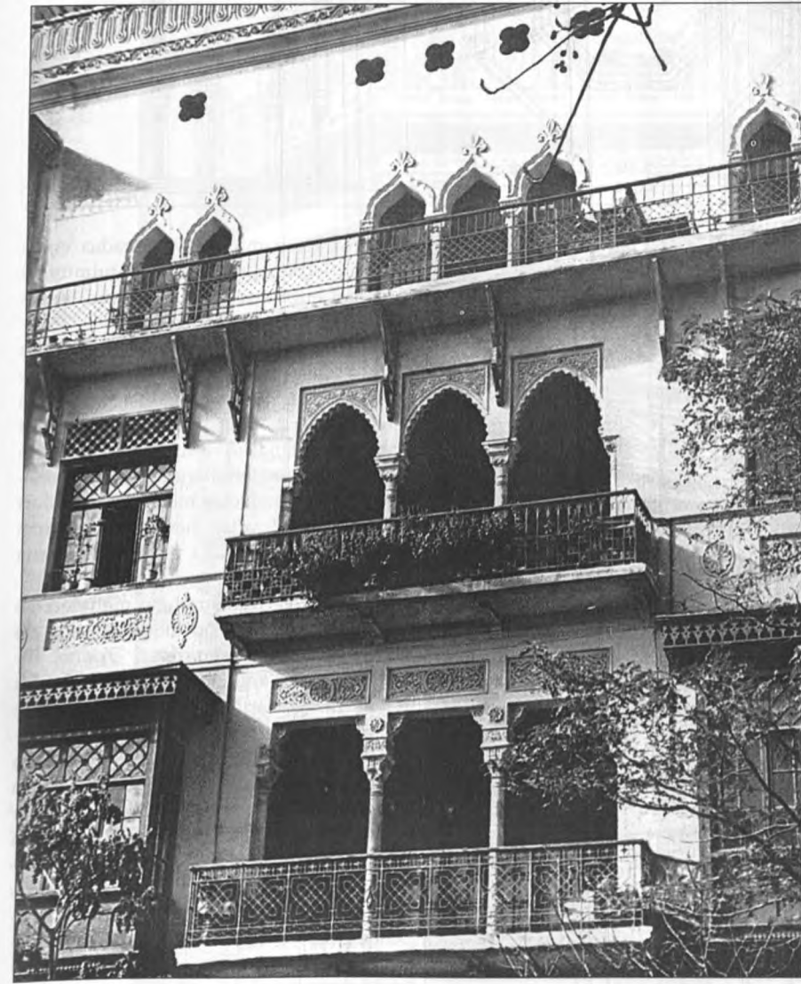
Sadiqov qardaşlarının Nikolayevskaya (Kommunist) küç. 21-də yaşayış evi. Fasad fraqmenti. Mülki mühəndis Q.M. Termikelov, 1912-ci il.
