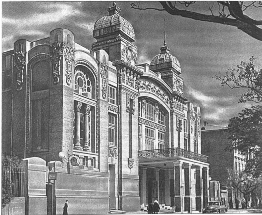
Bakı. Mayilovlar teatrının binası. Ön fasadın ümumi görünüşü. Ön (cənub) fasad.
