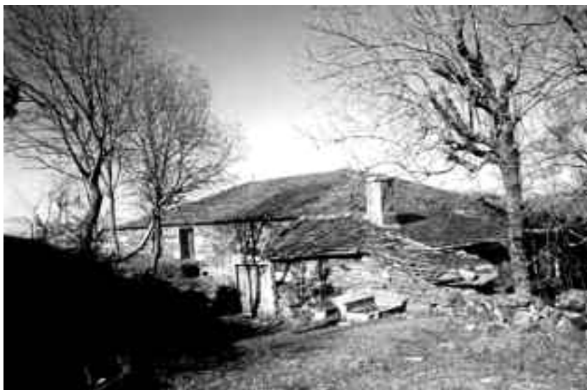
Acceso principal a la vivienda
