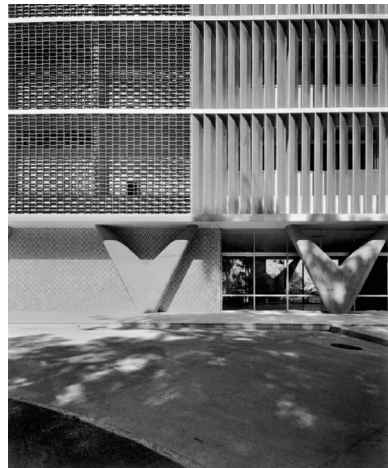
[11] Hospital Sul-América (atual Hospital da Lagoa), Oscar Niemeyer, 1952-1958. Nesta fotografia de Marcel Gautherot (1955) ficam em evidência três elementos criticados por Bill: os pilotis com “formas barrocas”, o painel de azulejos e os elementos de proteção à insolação (brise-soleil e cobogós).
