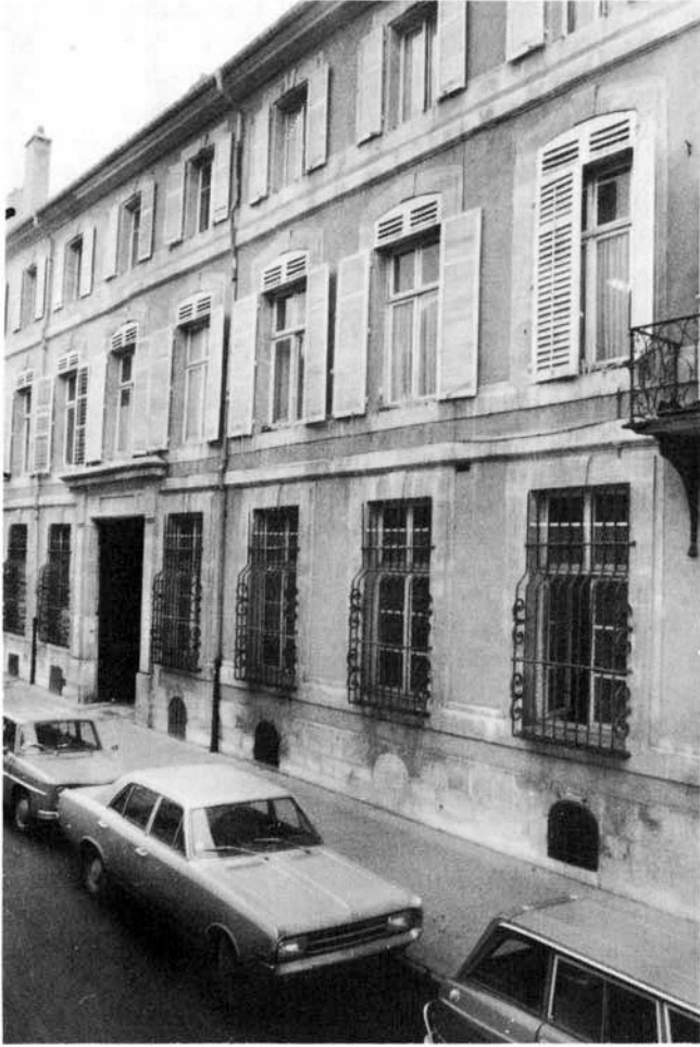
L'hôtel du baron de Vincent, 5, rue Lyautey à Nancy, avant sa destruction en 1977 : façade principale. Cl. A. Dagorn : © 1987 Inventaire Général.
