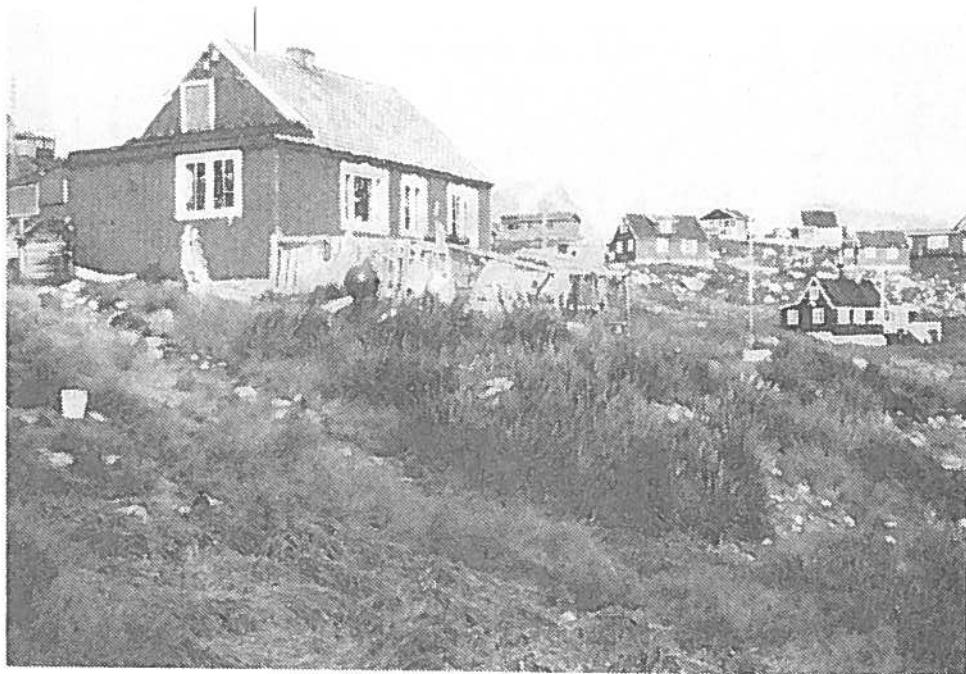
Småhusene på skråningsarealet. B-181 har bevaret ældre bygningsdetaller.
