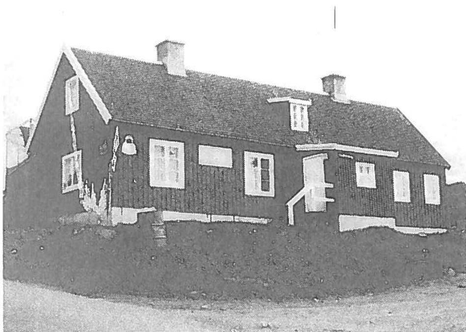
Medhjælperboligen B-48 - også kaldet "Skæven" - er en lang smal bygning opført omkring 1905 og udvi- det i 1920'erne.
