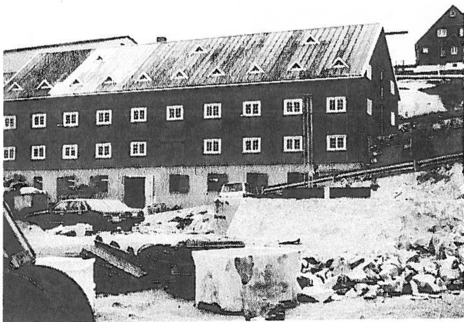
Pakhus B-20 på kajen og handelschefboligen oppe på fjeldet.
