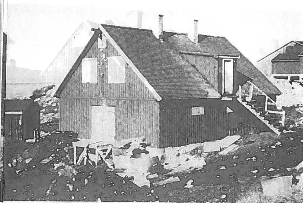
Spækhuset B-32 ligger i bunden af en lille vig nord for kolonien. Huset er opført 1912.
