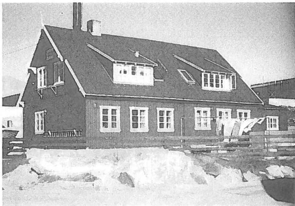
Den tidligere børneskole B-144 er opført i 1914.
