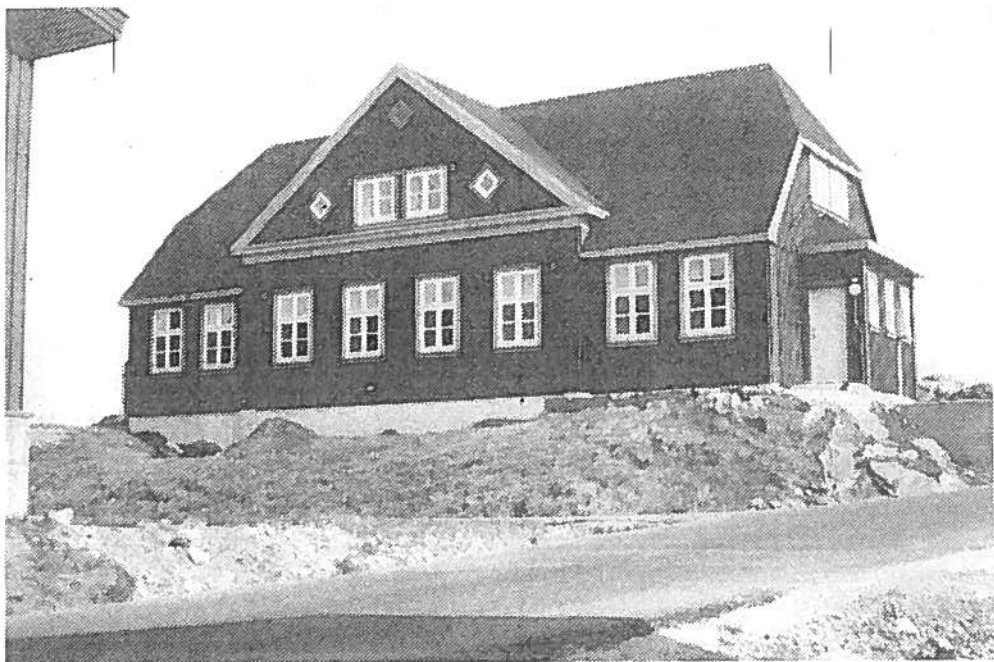
Seminariets økonomi- bygning B-148 er et markant hus opført i 1930'erne. Det er tegnet af Hel- ge Bojsen Møller.
