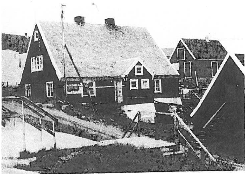
B-8 var oprindelig et hvalfangerhus, opført 1777 på nordsiden af havnen.
