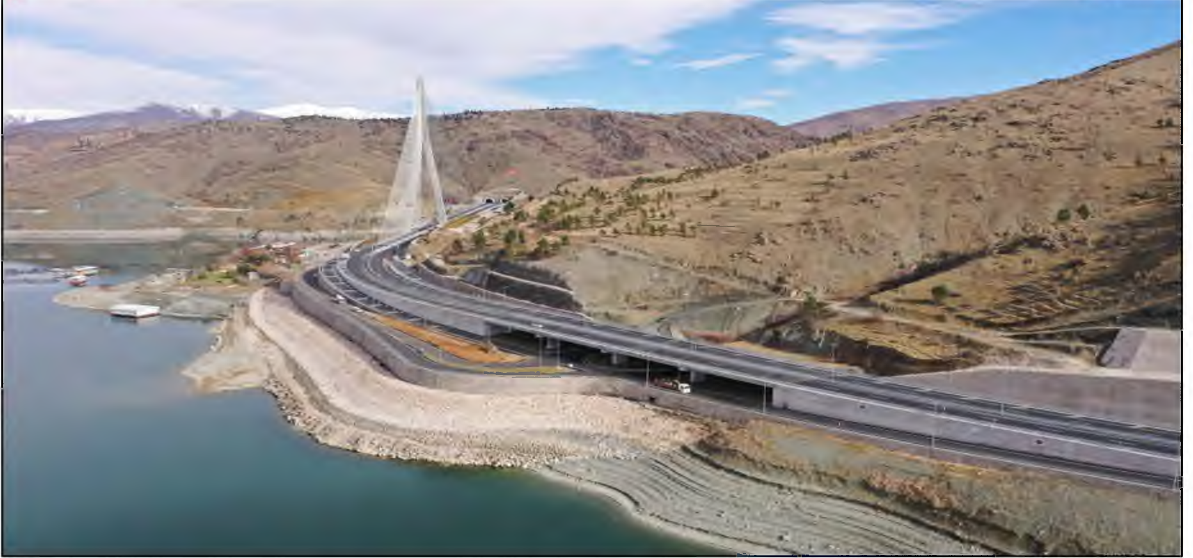
Kömürhan Köprüsü Genel GörünüŖ
