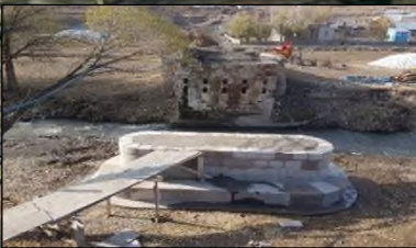
Tarihi Kötek II Ahşap Köprüsü(17,6 m)
