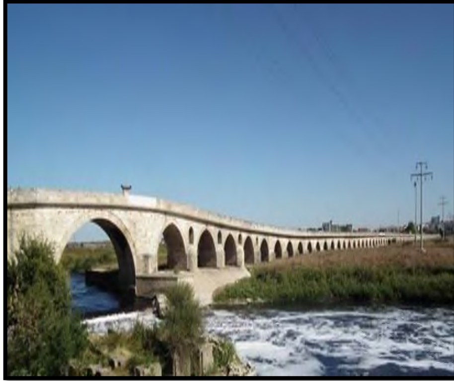
Tarihi Uzunköprü Genel Görünüm-1
