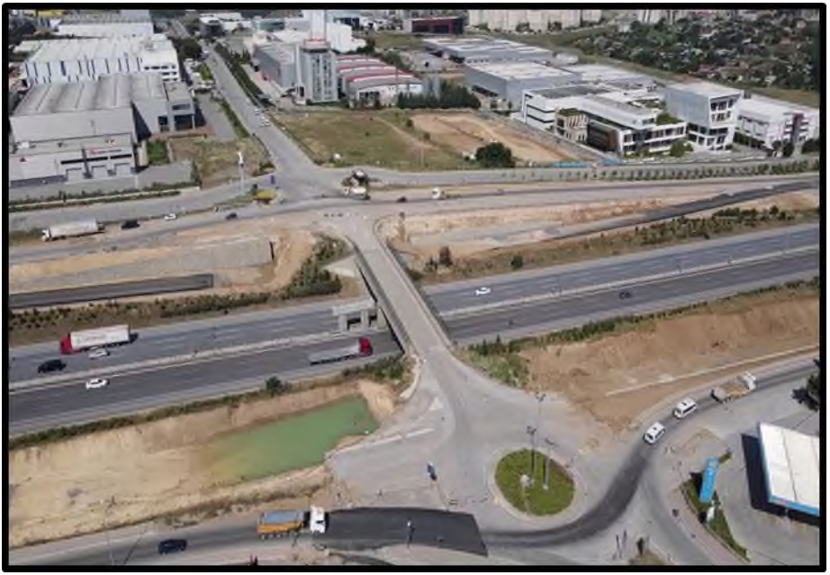
Tembelova Köprüsü (Köprünün tamamlanması için 8.300.000 TL ek ödeneĐe ihtiyaç vardır.)
