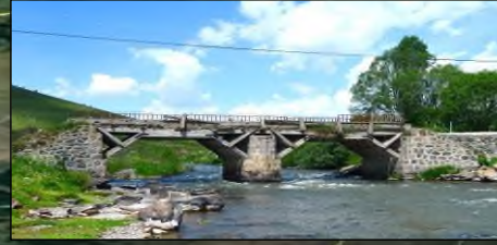
Tarihi Çayağzı Ahşap Köprüsü(17m)
