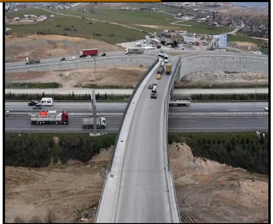
Bađlantı Yolu 4 Köprüsü
