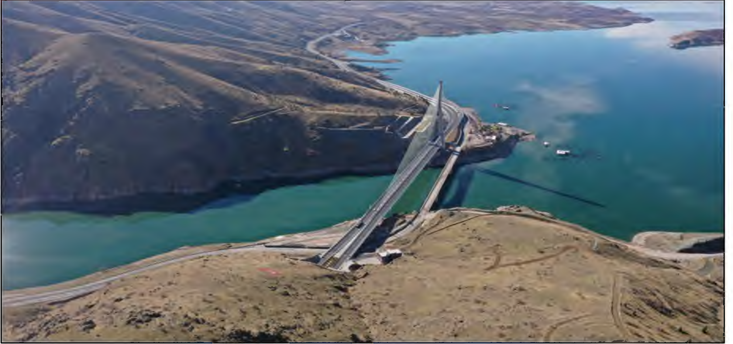
Kömürhan Köprüsü Genel GörünüŖ
