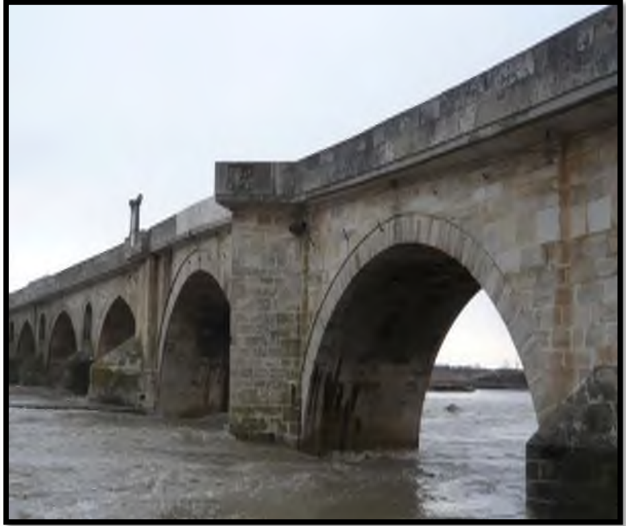
Tarihi Uzunköprü Genel Görünüm-2
