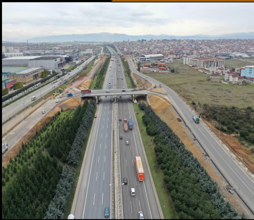
Bađlantı Yolu 1 Köprüsü
