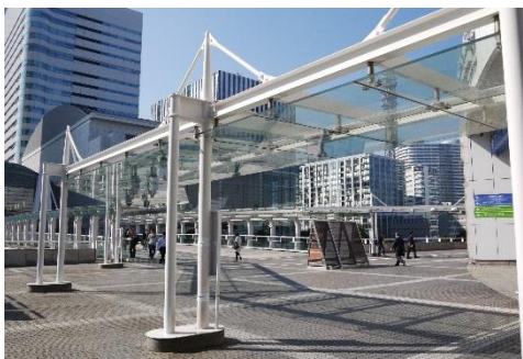
ペDESTリアンデッキの整備
