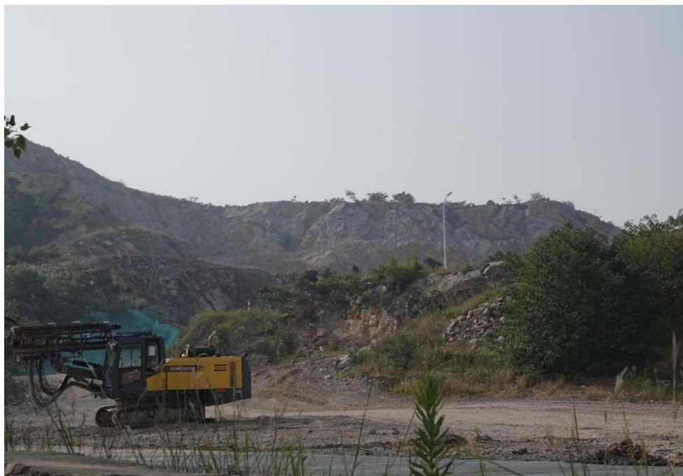
图 4.2-6 拟建隧道口现状
