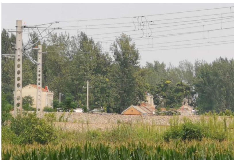
图 5.2-2 既有青阜铁路
