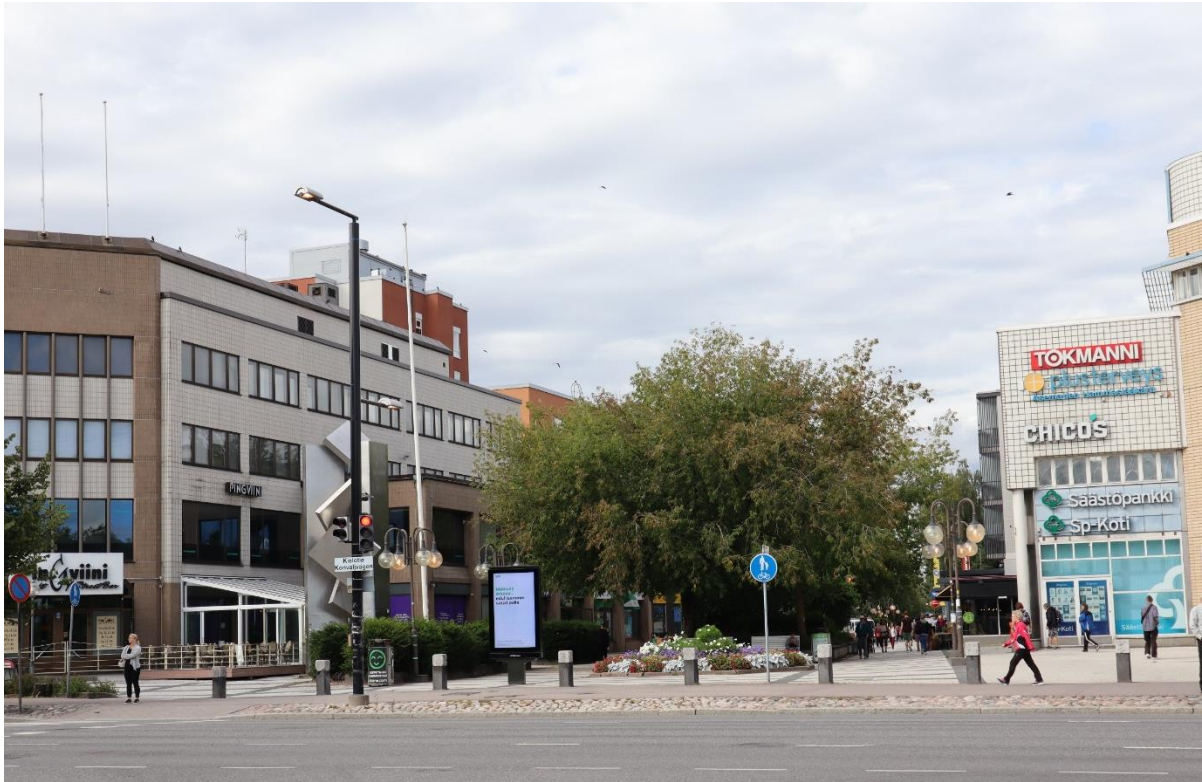
Tikkuraitin itäpää syksyllä 2020. Vasemmalla nyk. ravintola Pingviinin rakennus (V), arkkitehti Heikki Elomaa 1983 ja oikealla Tokmanni (V), suunnittelija insinööritoimisto Kaista & Sebbas 1985.
