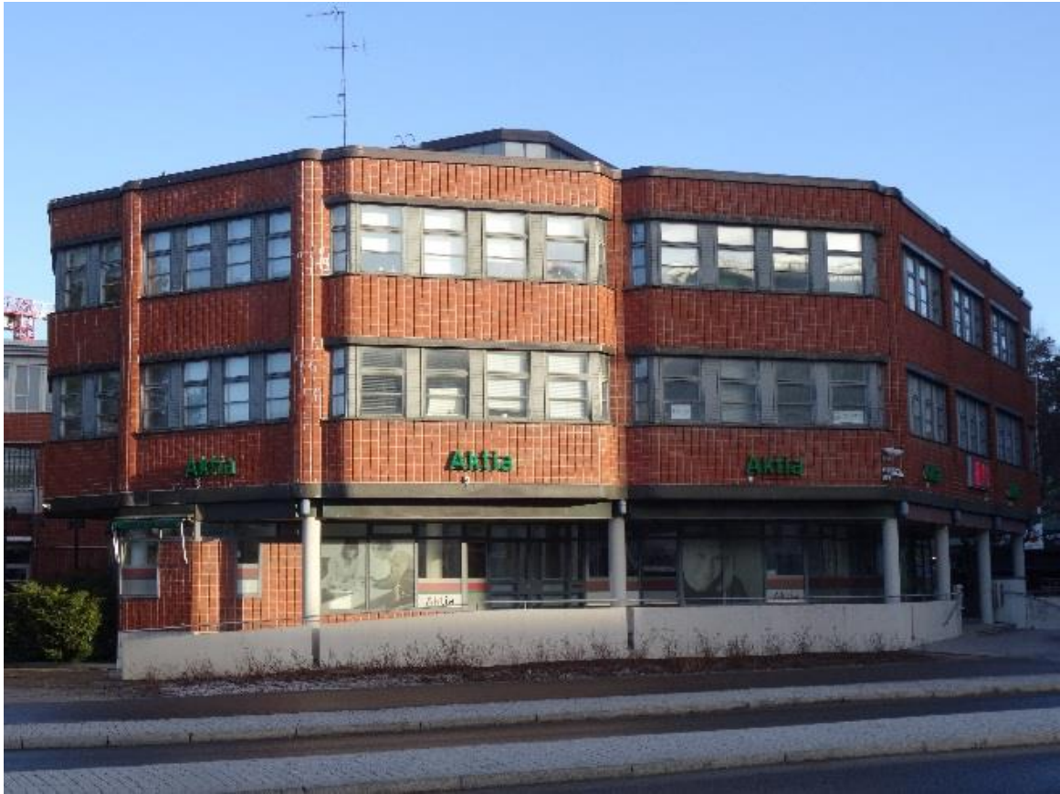
Raha-asema 1979 (R2), Arkkitehtitoimisto Kirsti ja Egil Nordin. Tikkurilan uusi asemarakennus valmistui 1978 (purettu 2015). Sitä vastapäätä Tikkurilan keskustan sisäänkäyntiin Asematien varrelle nousivat mm. Raha-asema 1979 ja Asematien toiseen päähän Terveysasema 1974. Asematien eteläpuoli täydentyi myöhemmin punatiilipintaisella Tikkurin toimisto-osalla 1984 ja Tikkurin kauppakeskuksella 1991.
