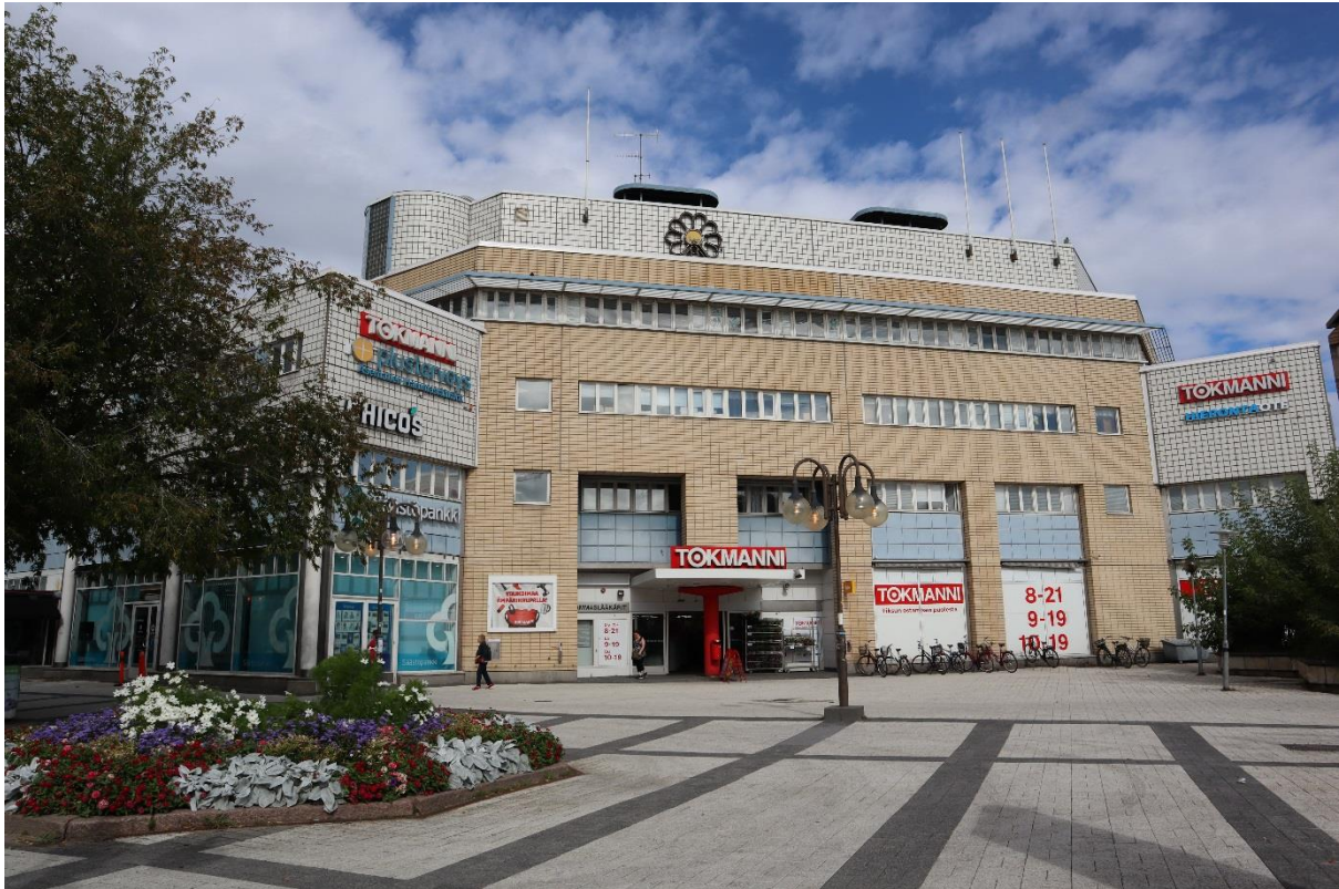
Tokmanni (V), suunnittelija insinööritoimisto Kaista & Sebbas 1985. Tokmannin tontilla on aiemmin ollut useita Elannon kaupparakennuksia, joista muistuttaa Elannon kukkalogo rakennuksen katolla.
