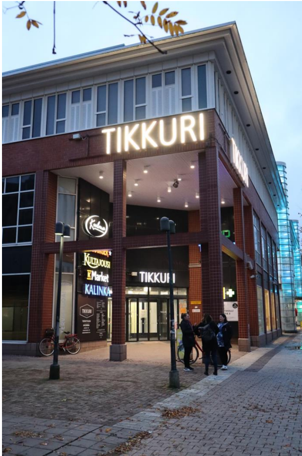
Tikkurin kauppakeskuksen (R2) pääsisäänkäynti suuntautuu koilliseen, kohti rautatieasemaa.
