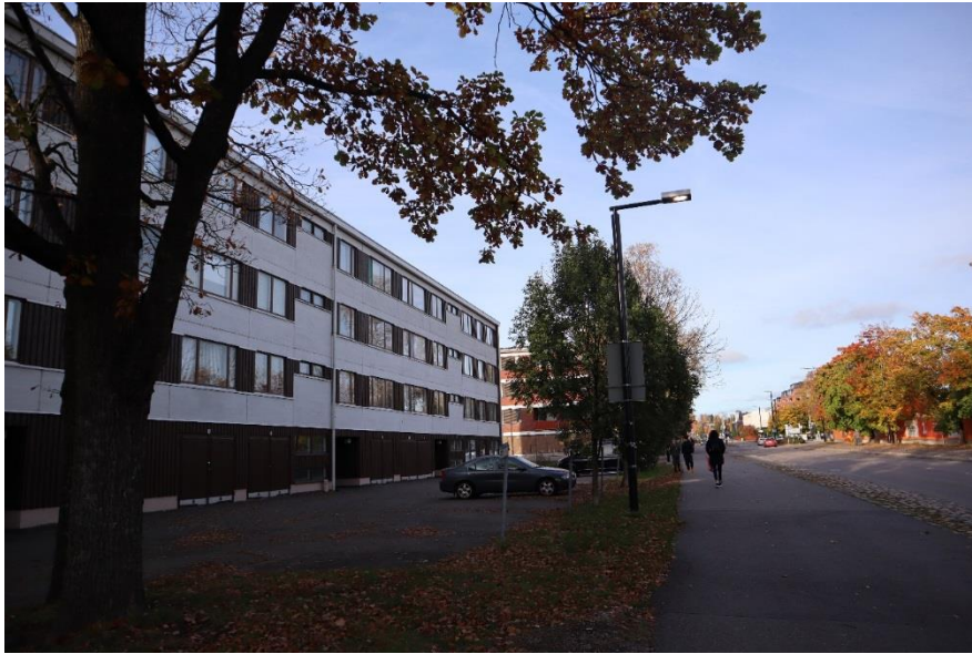
Kielotie 30-32 1966 (V). Takana Kielotie 34-36, 1969. Tikkurilan keskustan läpi kulkevan Kielotien varrella näkyy vielä 1960-luvun matalaa kerrostalorakentamista. Rakennukset edustavat aikansa tyyppistä rakentamista mutta niiden todetut arvot eivät olleet riittäviä suojeluperusteiksi.
