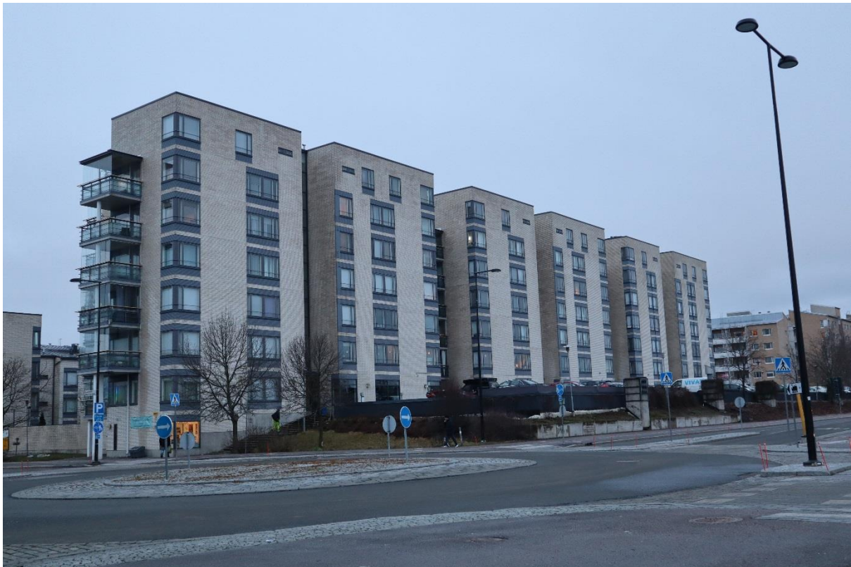
Rautatien länsipuolella sijaitseva, Arkkitehtitoimisto Gullichsen-Vormalan suunnittelema kerrostaloasuntojen kokonaisuus, Lummetie 1 / Veturikuja 4 (V) valmistui vuonna 1997. Rakennus näkyy junaradalle ja on edustava näyte 1990-luvun asuntoarkkitehtuurista.
