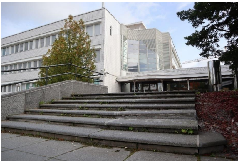
Oikeus- ja poliisitalon länsisivun pääsisäänkäynti ja portaikko.
