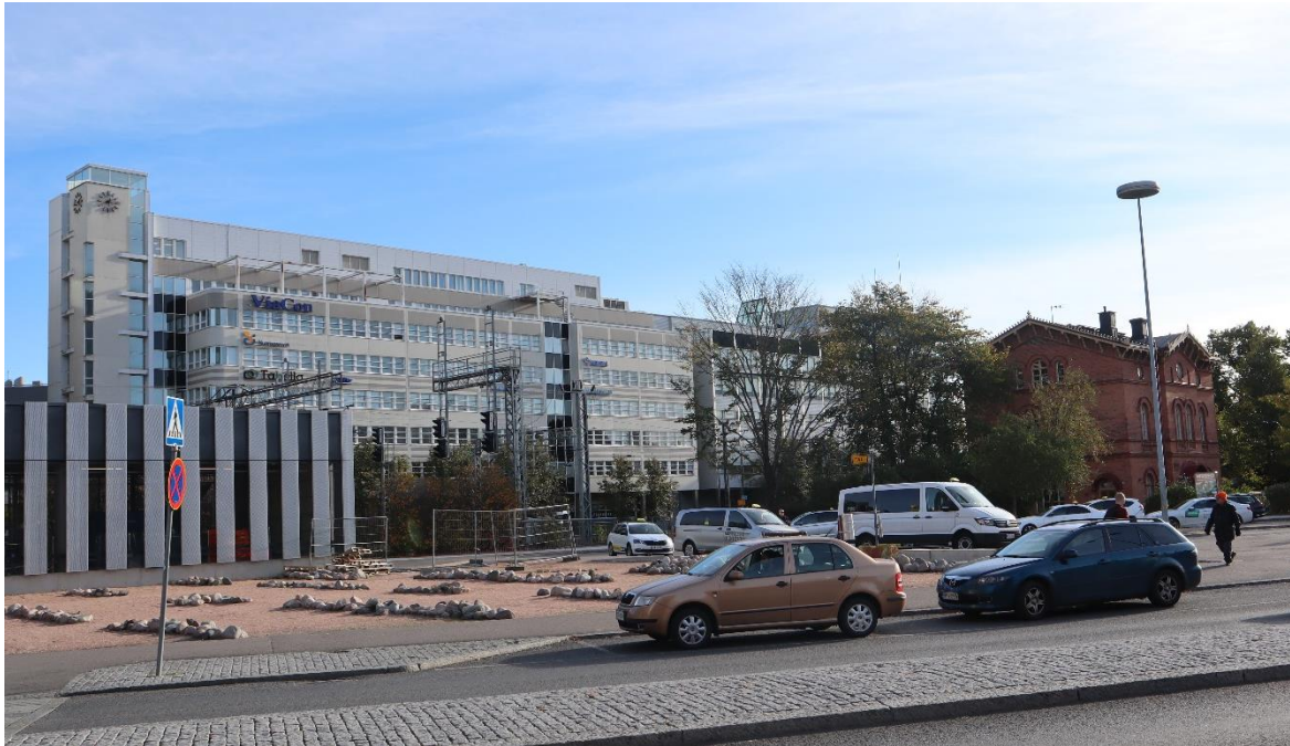
Tikkurilan Asemankello/Big Ben (V), toimistorakennus Tikkurilan rautatieaseman itäpuolella. Arkkitehti Jaakko Laapotti 1991. Rakennuksen länsijulkisivu kohti asemaa.
