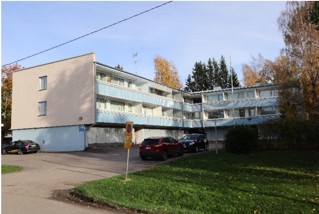
Orvokkitie 5, 1964 (V). Rakennuksessa on 1960-luvulle tyypillinen valetasakatto, joissa räystäään yli nostettu päätyseinä peittää katon todellisen muodon.
