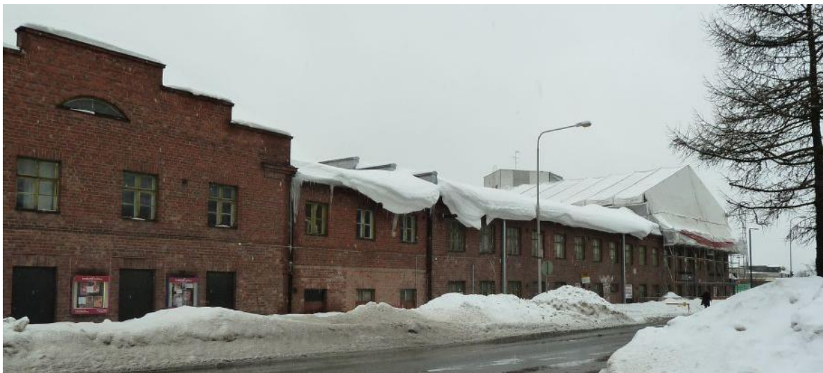
Tikkurilan jo suojeltua rakennettua kulttuuriympäristöä: Tikkurilan vanha asema 1862 (RKY), Vernissatehdas 1912 ja Silkkitehdas 1930-luku. Kohteet on arvotettu luokkaan R1, erityisen merkittävät kulttuurihistorialliset arvot.
