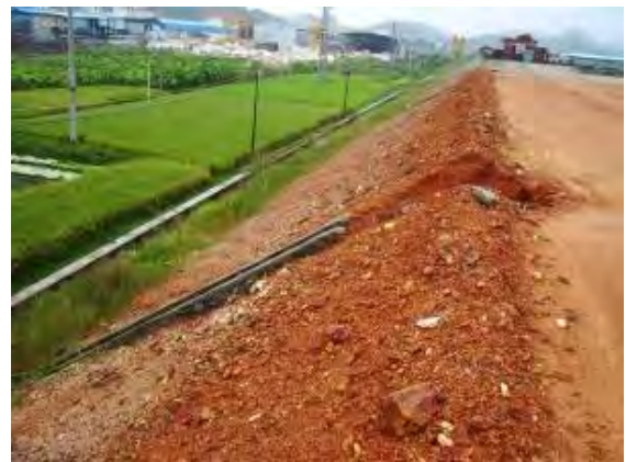
路基急流槽排水
