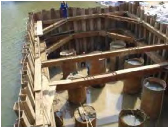
桥梁施工钢板围堰
