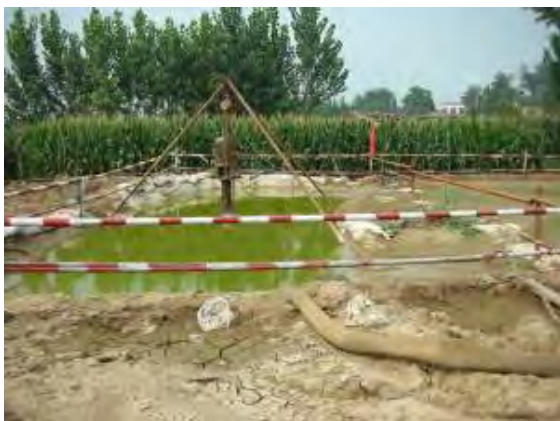
桥梁施工泥浆池防护
