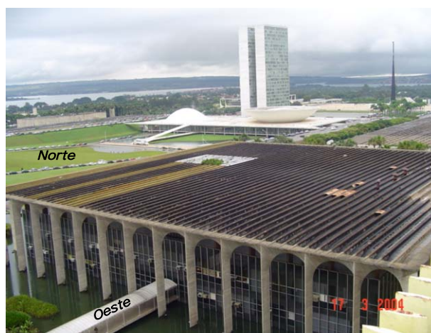
Figura 3: Cobertura e Fachada Oeste do Palácio do Itamaraty, tendo ao fundo os edifícios do Congresso Nacional e a Praça dos Três Poderes.
