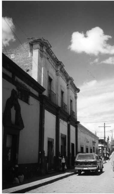
Edificio del cine Pradera
