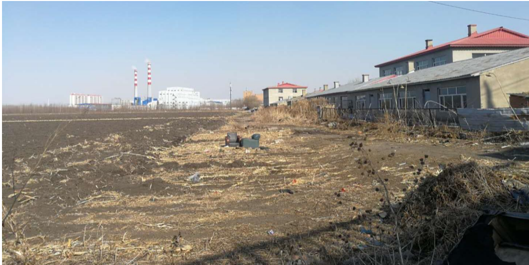
裕民牵引变电所选址实景图 (a) 裕民牵引变电所
