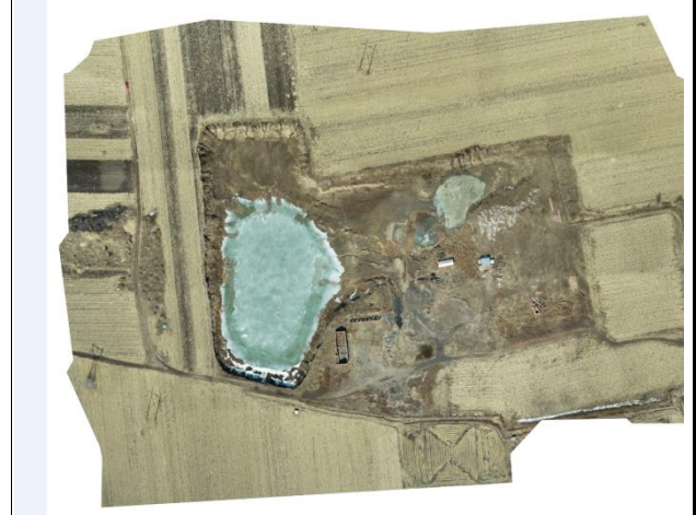
永胜弃土场航拍图
