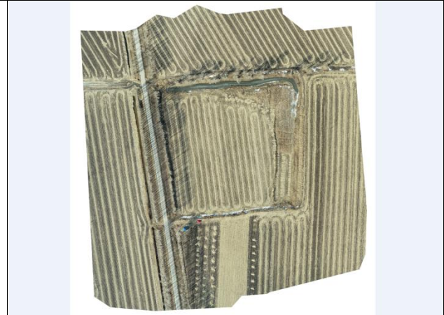
建成村 02 号弃土场航拍图
