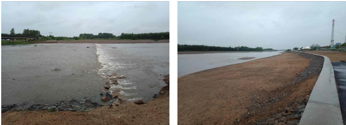
桥址处呼兰河
