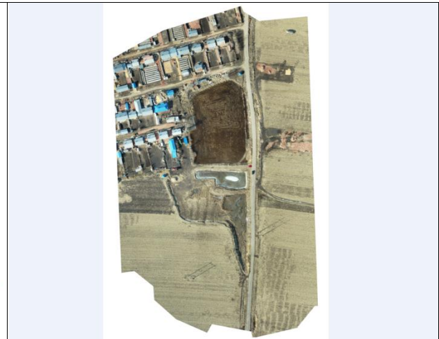
冯克兴弃土场航拍图
