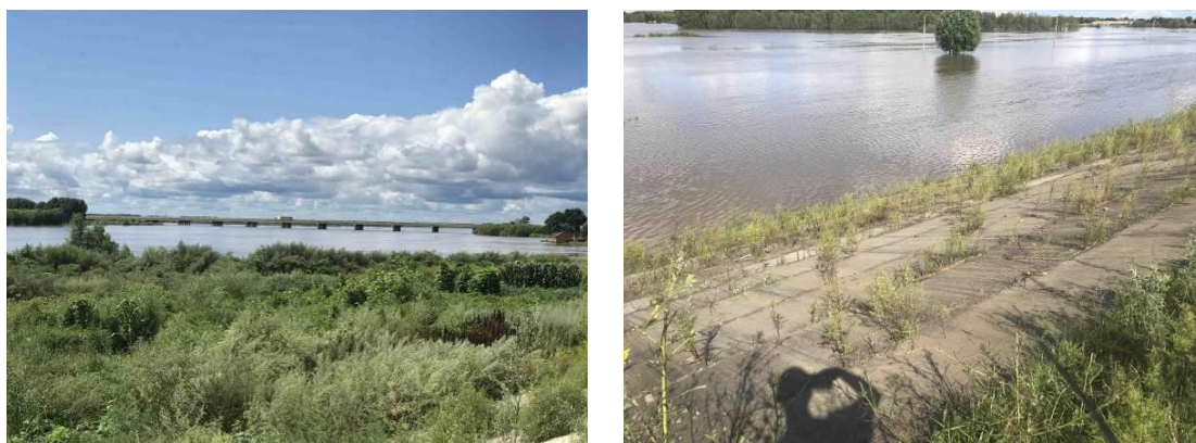
呼兰河特大桥跨越处
