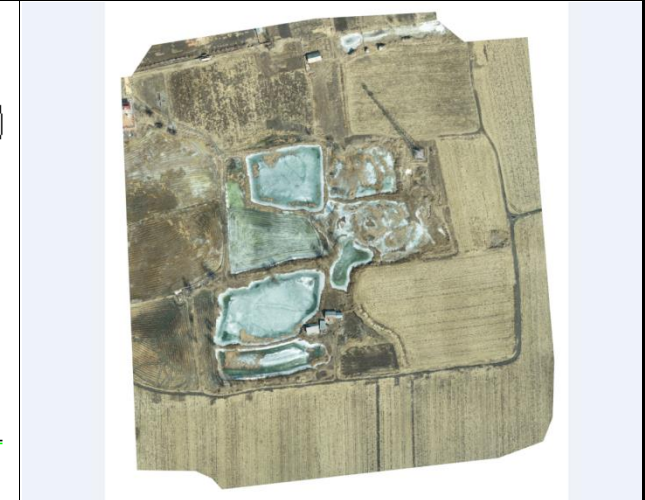
蒲井村弃土场航拍图
