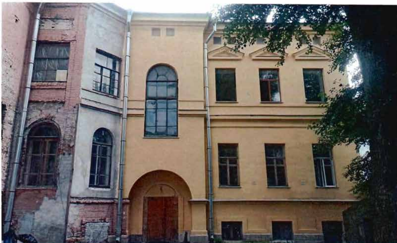
2. Фрагмент западного фасада объекта культурного наследия.
