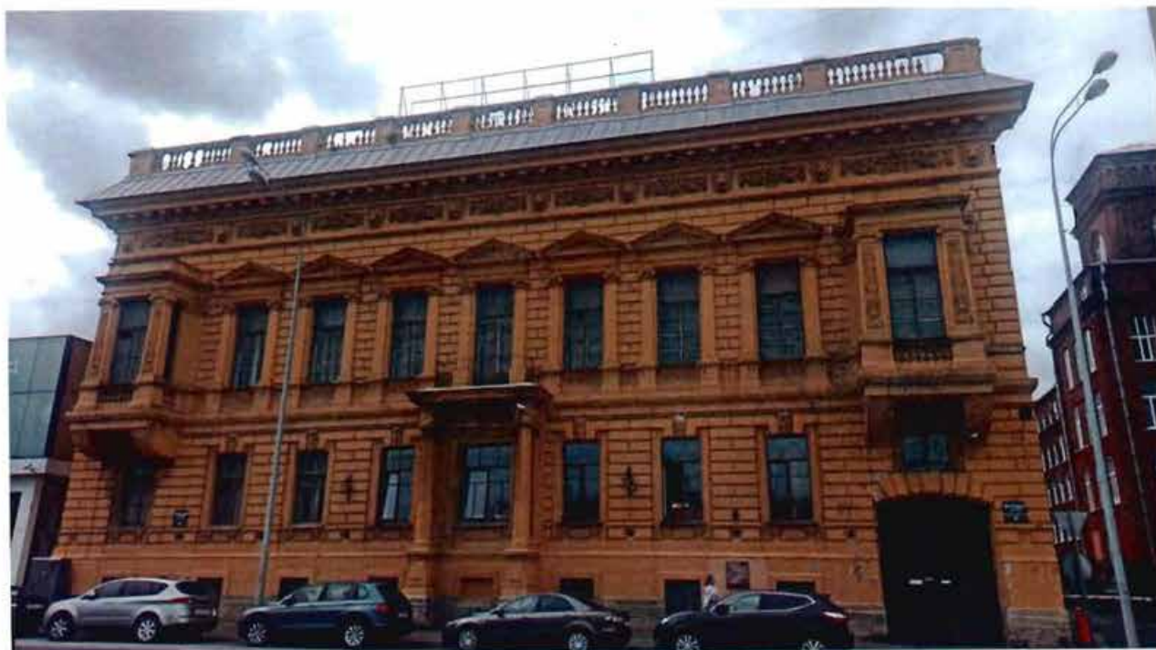
1. Вид на объект культурного наследия с восточной стороны. Лицевой фасад.
