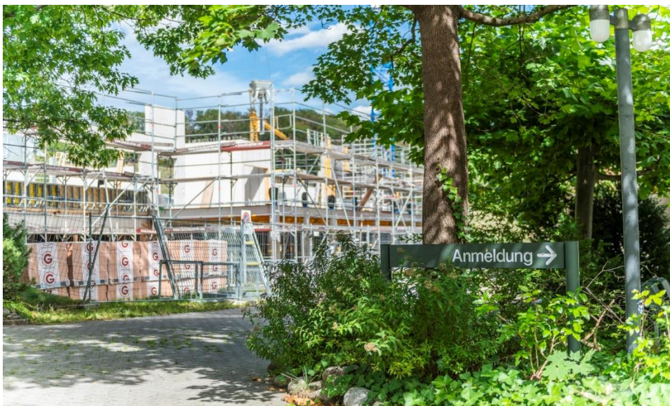
Baustelle der ersten Etappe September 2020 und Rückbau/Sprengung Oktober 2018
