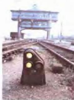
**4-bis.** In determinate stazioni di testa può essere impiantato, in prossimità del paraurti, un segnale ripetitore per la retrocessione in manovra dei treni in arrivo.
