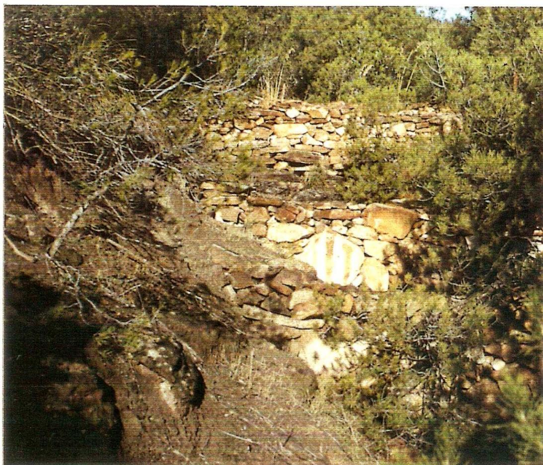
Seuils de correction torrentielle tels qu'établis dans la zone préaménagée. Le volume et l'écartement des ouvrages n'ont pas fait l'objet de calculs d'origine hydrologique.
