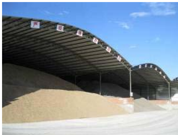
拌合站中砂、碎石密闭存放
