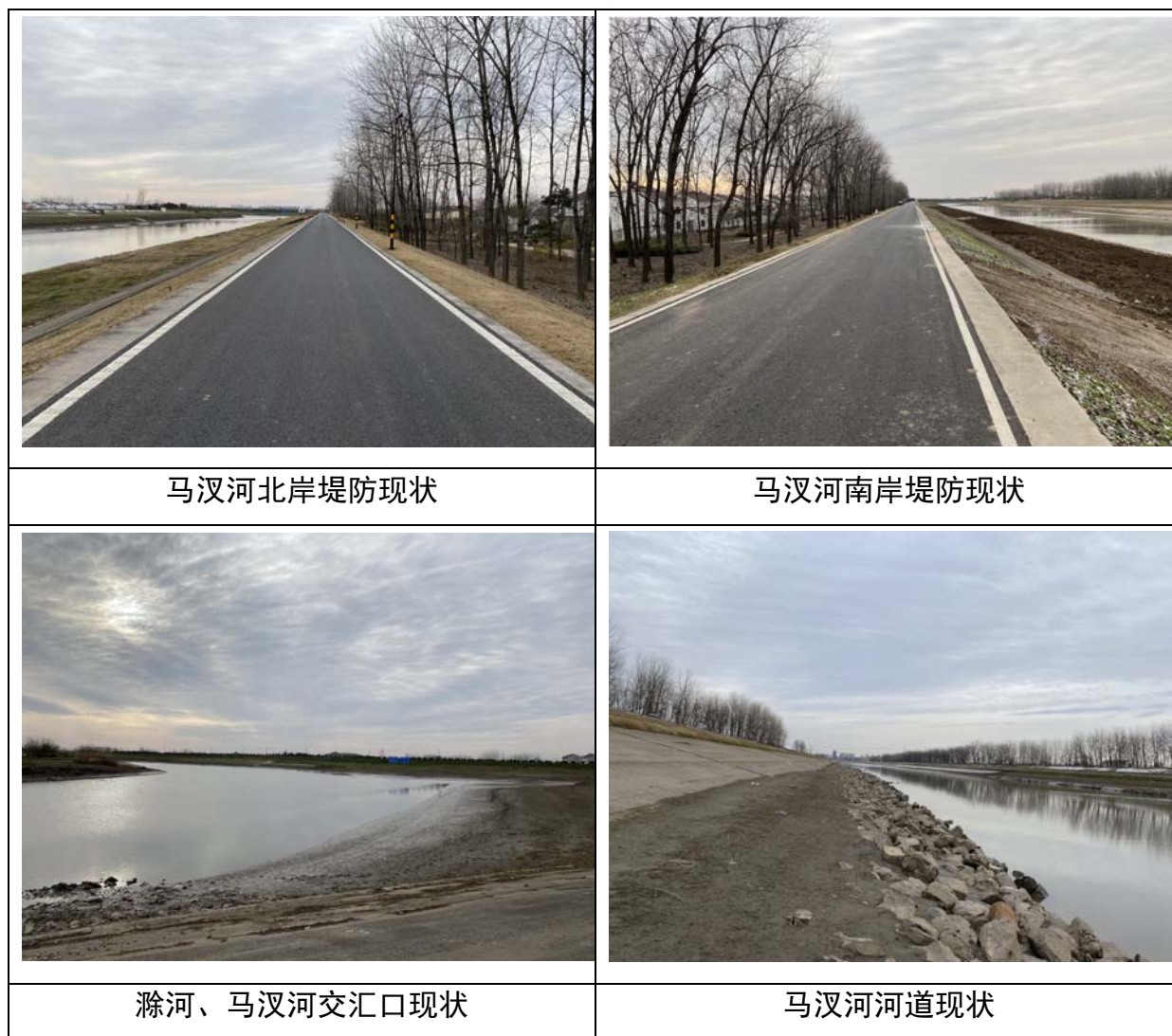
图 4.5-4 马汊河洪水调蓄区现场图片
