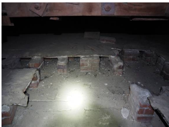
圖 3-110 原始屋頂上鋪設空氣層
