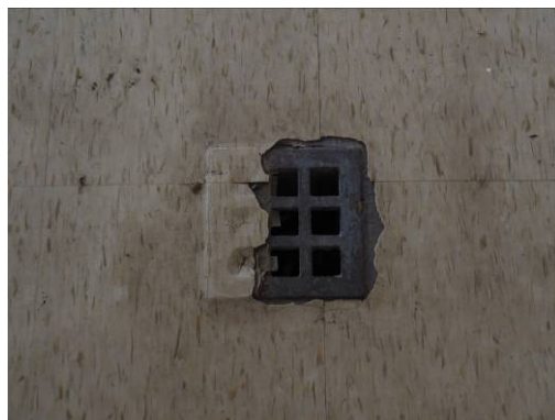
圖 3- 230 [R21]樓板通氣口
