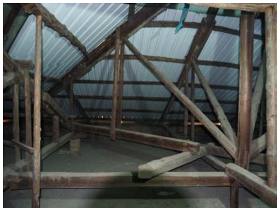
圖 4-17 [R17]補強支撐
