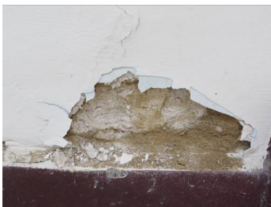
圖 3-148 [R05]牆面漆喰含有砂土
