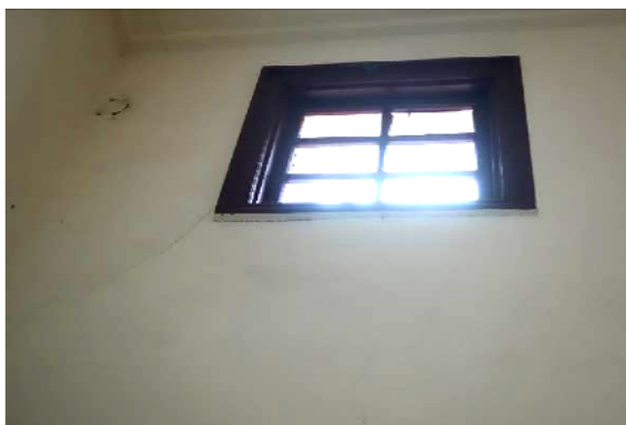
圖 5-33 開口部角隅斜向裂縫
