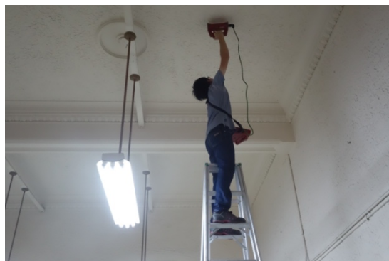
圖 5-59 鋼筋檢測 編號 9：1F 頂版-9
