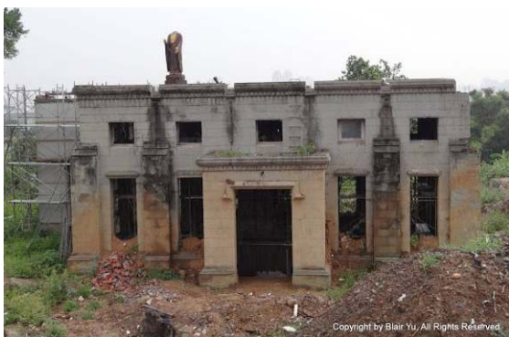
圖 3-16 新竹水道取水口（1913）
