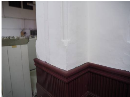
圖 3- 150 1925 牆柱轉角修飾第一型
