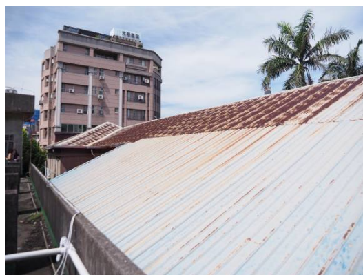
圖 3-128 現況鐵皮屋頂
