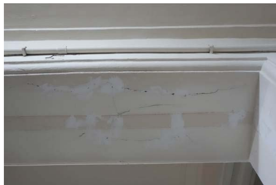
圖 5-14 RC 楣樑開裂
