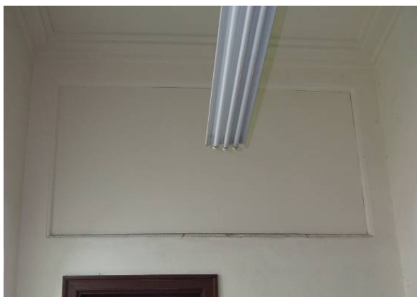
圖 3- 236 [R16]面向[R15]處修飾框 六、 書庫地板鐵門
