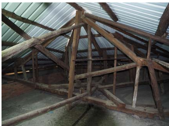
圖 4-12 [R03] 上方最外側的屋架變形
