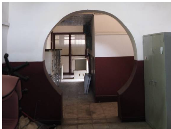
圖 3-206 圓洞門正面現況
