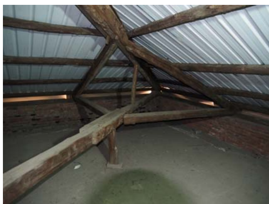
圖 4-15 [R17]補強支撐
