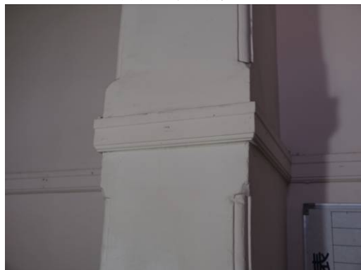
圖 3- 153 1925 牆柱轉角修飾第二型
