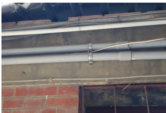
圖 5-35 開口部角隅斜向裂縫
