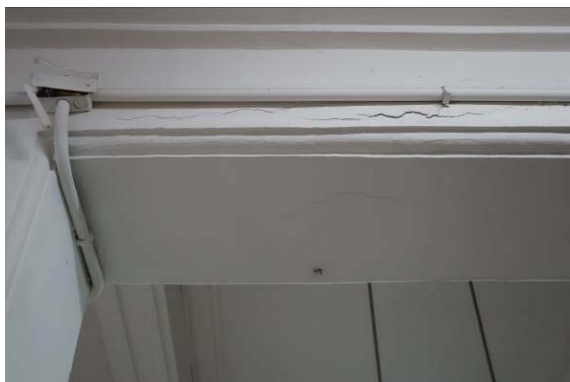
圖 5-13 RC 楣樑開裂
