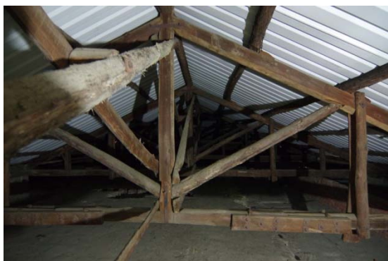
圖 5-7 西式之正同柱式木屋架
