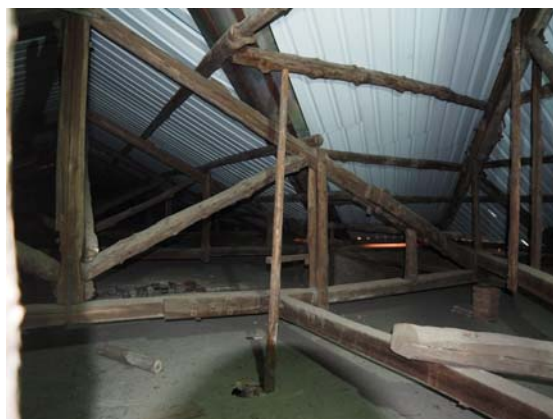
圖 4-13 下方無牆柱之平屋頂支承屋架
