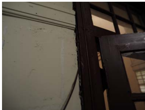
圖 3-187 線路由壁面線板上方向下
