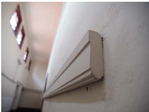
圖 3-186 壁面線板
