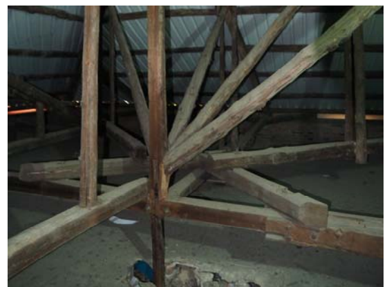
圖 4-16 [R17]補強支撐
