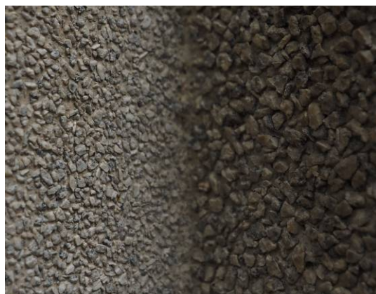
圖 3- 140 洗石子對比 左:1925，右 1932（顏色差為現場陰影） （一） 平面洗石
