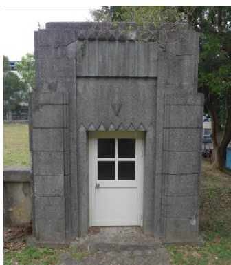
圖 2-53 1926 新竹水道水源地
