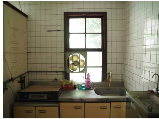
圖 3- 241 [R14]廚房設備
