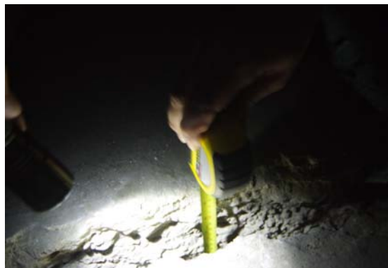
圖 4-4 裂縫深度已穿入樓板
