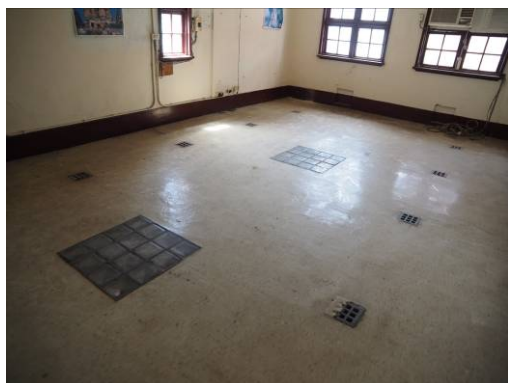
圖 3- 228 [R21]樓板通氣口與採光玻璃
