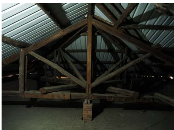
圖 4-14 [R17]補強支撐
