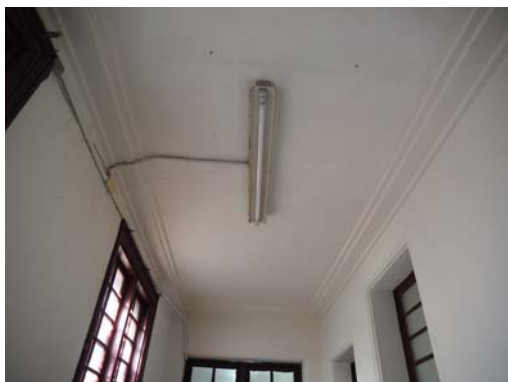
圖 3- 244 燈具線路採用明管架設 (三) 機械通風設備
