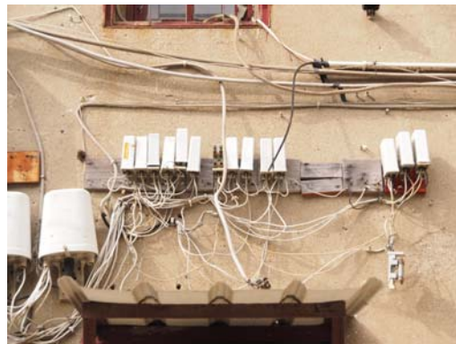
圖 4-27 外牆裝設後期設備
