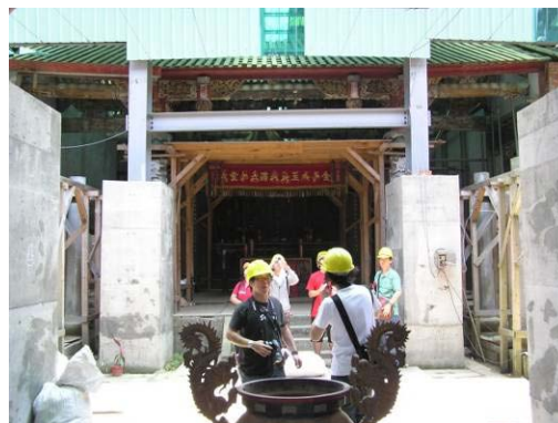
圖 6-12 供民眾參觀之古蹟修復現場
