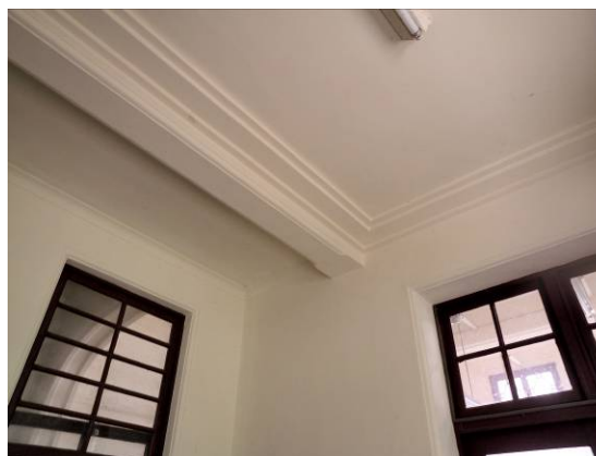
圖 3- 237 [R15]處補強梁
