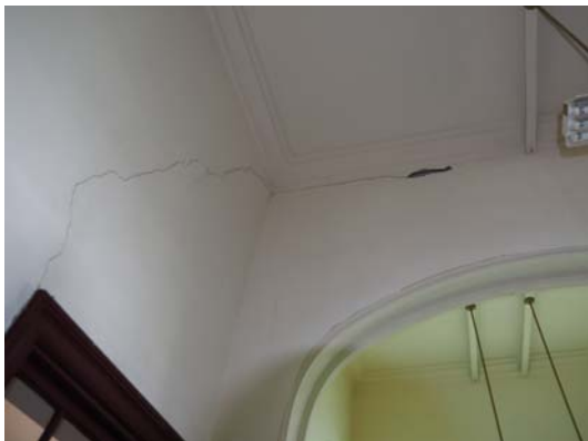
圖 4-9 [R09]與[R16]內牆裂縫
