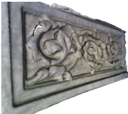
圖 3- 265 左側泥塑莨苳 3D 掃描
