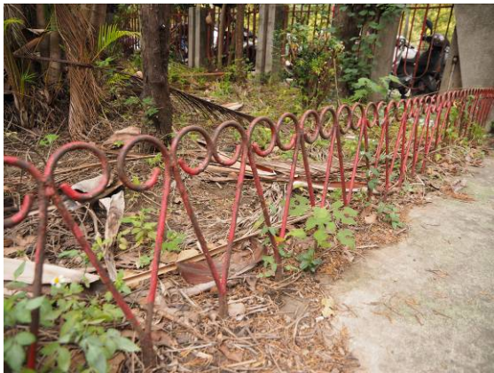
圖 3-46 鑄鐵欄杆圍籬
