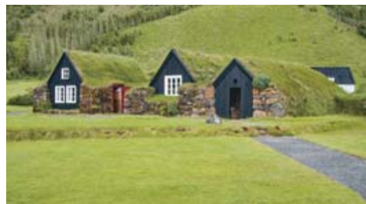
Essas casas de turfa estão localizadas na Islândia, Europa. A cobertura de grama e de outras plantas ajuda a manter o calor no interior das moradias durante o inverno.
