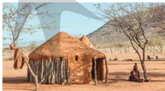
As moradias do povo himba são feitas de galhos de árvores revestidos com barro. Essa foto foi tirada na Namíbia, país localizado na África.
