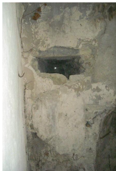
Fig. n° 176. Archère perçant le mur 3 à l'extérieur. B. Ouverture presque toute bouchée de l'ébrasement de l'archère du mur 3 (cl. M. Varano).
