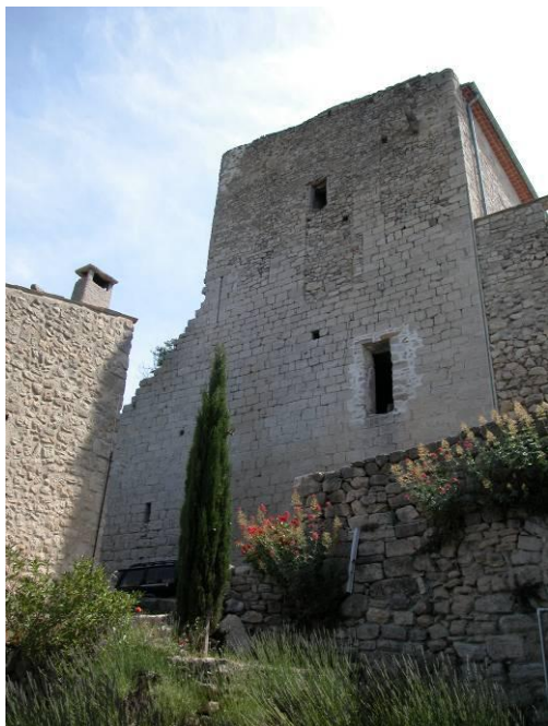
Fig. n° 148. Angle sud-ouest de la résidence épiscopale (cl. M. Varano).
