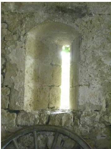
Fig. n° 58. Église de la Conseillère à Vachère. A. Ébrasement asymétrique intérieur du jour percé sur la façade méridionale. B. Arc triomphal et cul-de-four de l'abside (cl. M. Varano).
