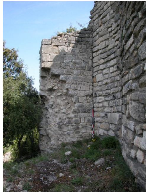
Fig. n° 189. Angle formé par les murs 20 et 21, au nord du mur du château d'eau (cl. M. Varano).
