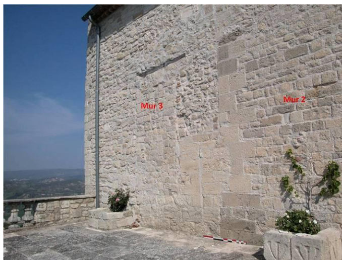
Fig. n° 175. Mur 3 délimitant au sud la tour B (cl. M. Varano).
