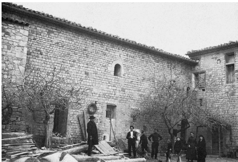
Fig. n° 123. Façade méridionale de l'église en 1916 (J.-Y. Royer, Forcalquier (1986)).
