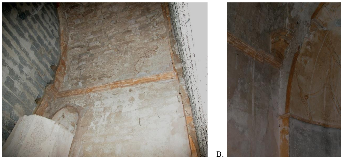
A. B. Fig. n° 118. A. Vue de la frise soulignant le départ du berceau dans la deuxième travée, côté sud. B. Jonction entre la frise et la console de l'arc triomphal, côté nord (cl. M. Varano).
