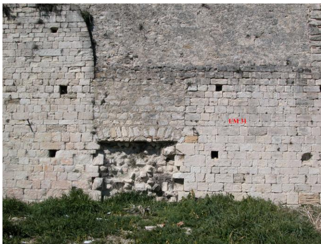
Fig. n° 10. Saint-Mary, mur 31 avec l'arrachement intermédiaire (cl. M. Varano).
