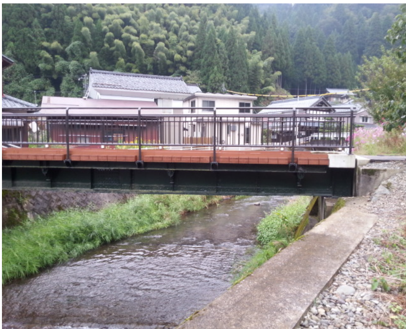
京善橋 改修後
