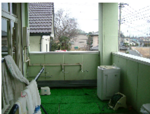
Fig.3 2階踊り場に設置された水場
