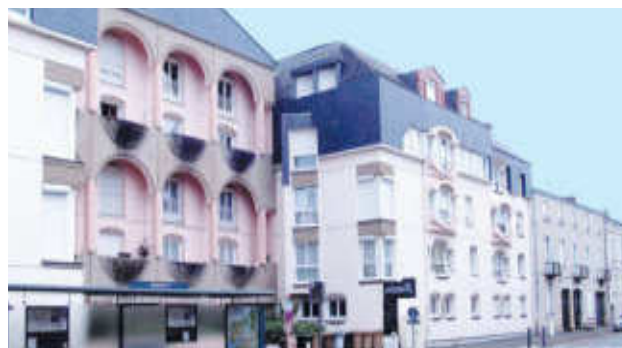
Частный жилой дом, г. Анже, 1980
