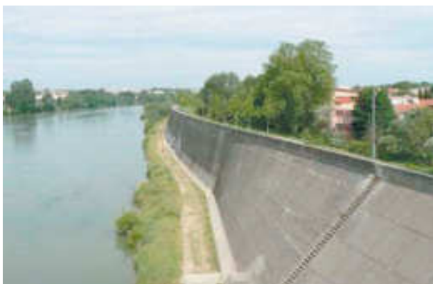
Берегоукрепительные работы на левом берегу Гаронны у мостов-близнецов в Бланьяке, Тулуза, 1965
