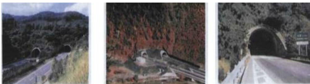
图 4-2-4 无洞门的洞口技术
