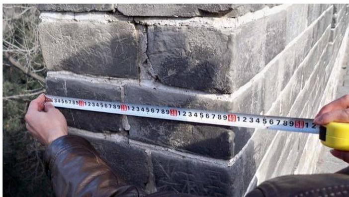
图 6-2-10 长城断面尺寸实测图
