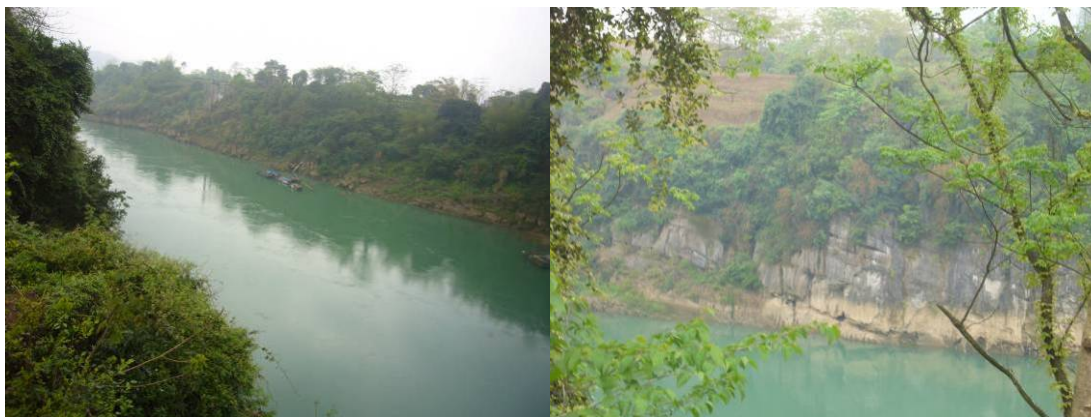
图 2.1.4-9 CK395+030 红水河双线特大桥
