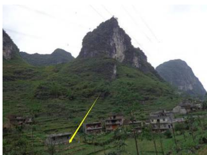
图 3.1.3-1 都安隧道出口危岩落石照片
