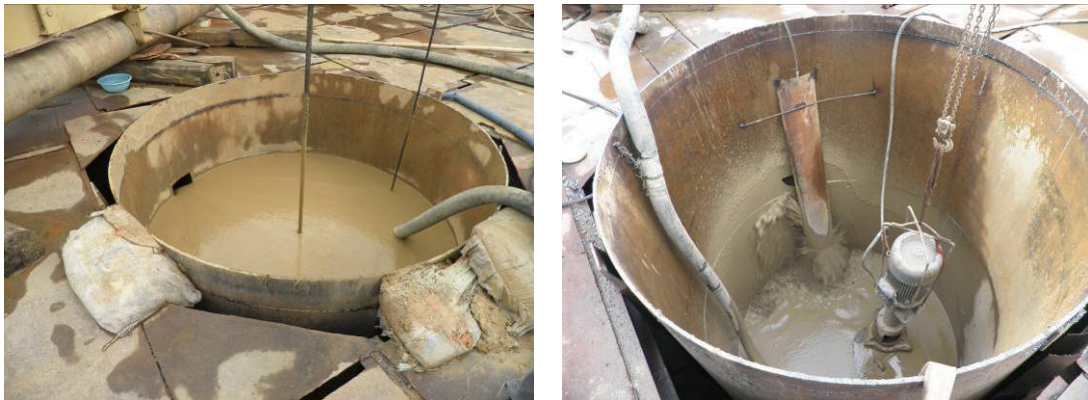
桥梁钢围堰施工
