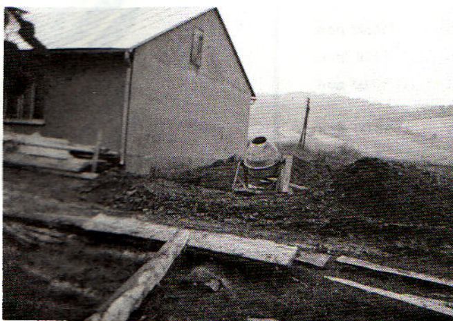
Праця йде вперед Кладуть бетонні лави під фундаменти.
