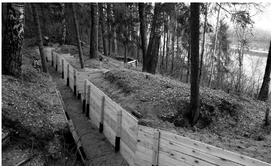
Рис. 2. Реконструкция одежды подлинной траншеи (фото В.П. Новикова)
