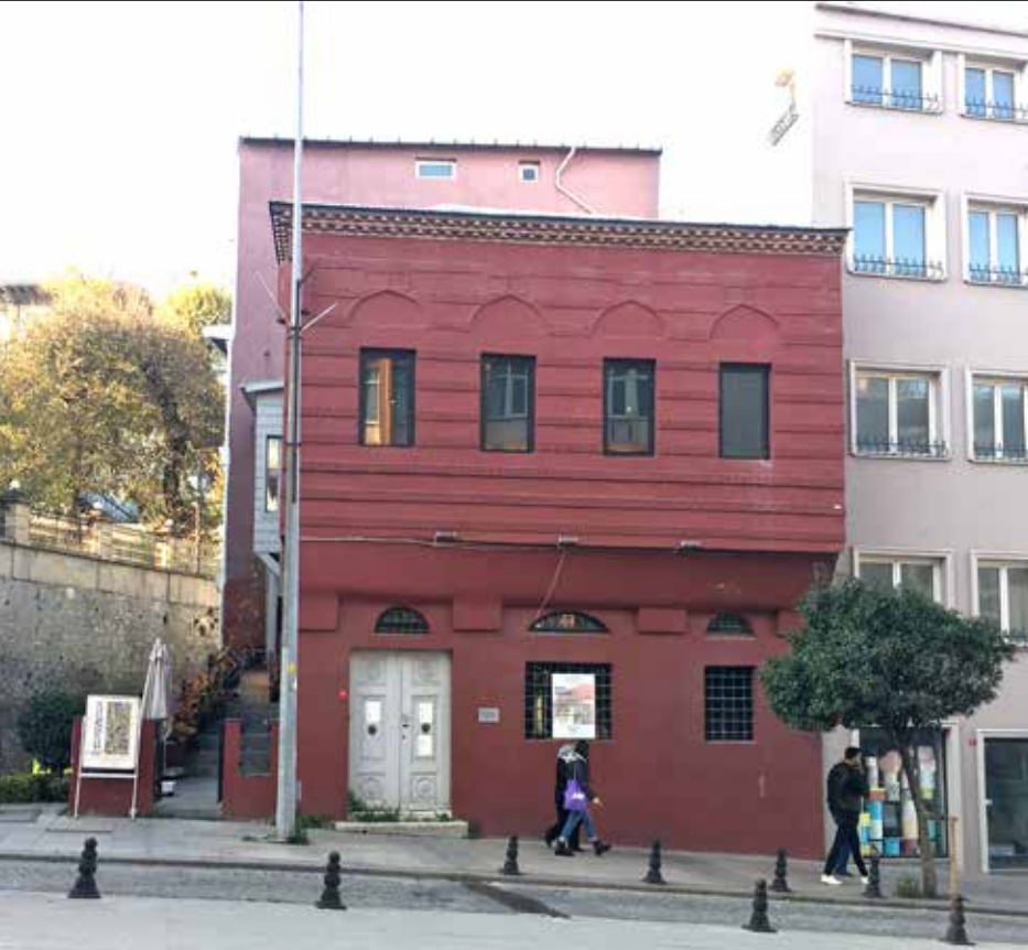
Taşmektep binası, şimdi resim, heykel, video-art, enstalasyon atölye ve eğitim çalışmaları yapan Bağımsız Sanat Vakfı tarafından kullanılmakta olup iç tasarımında bir de sanat galerisi düzenlemesine yer verilmiştir.
