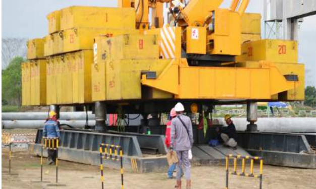
Pembangunan Pabrik Pupuk NPK
