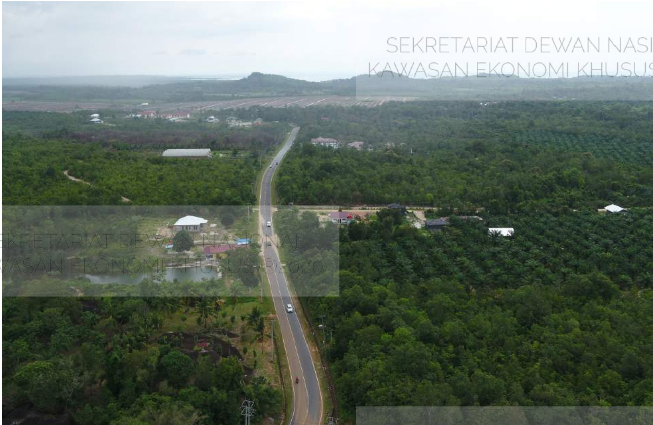
Jalan Nasional akses menuju KEK Tanjung Kelayang
