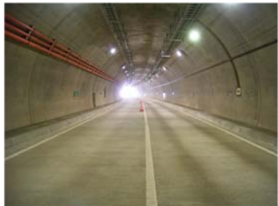
■新トンネル (トンネル内から広尾側)
