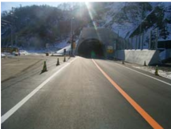
■新トンネル (広尾側坑口)
