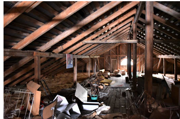
Kuva: Kylmäullakko ja katon puurakenne.
