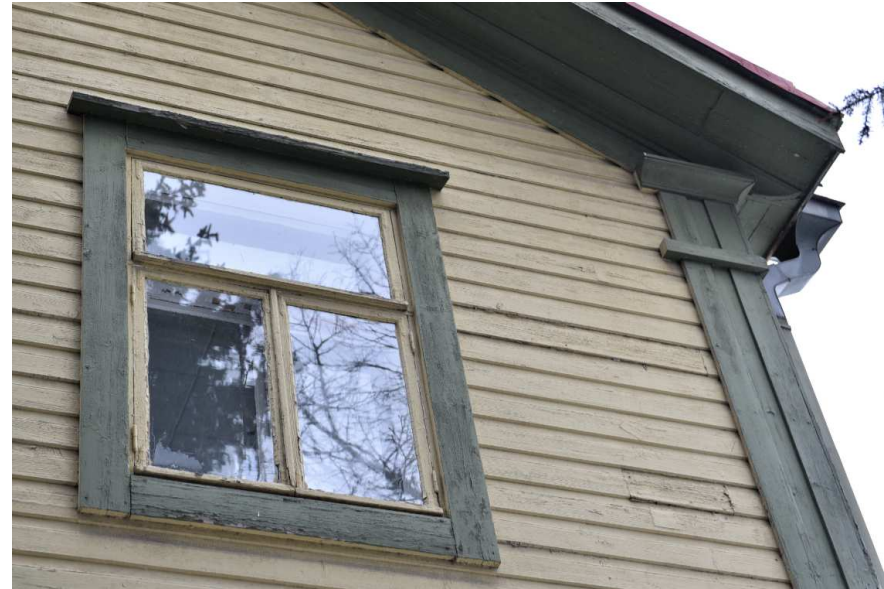
Kuva: Nurkkapilasterin kapiteeliosa ja umpiräystään profiloidut kattolistat. Vanha peltinen suppilo ja syöksytorni. Yläkerran T-karmillinen sisään-ulos -aukeava ikkuna. Suorat vuorilaudat ja ylävuorilaudan kallistettu vesilauta.
