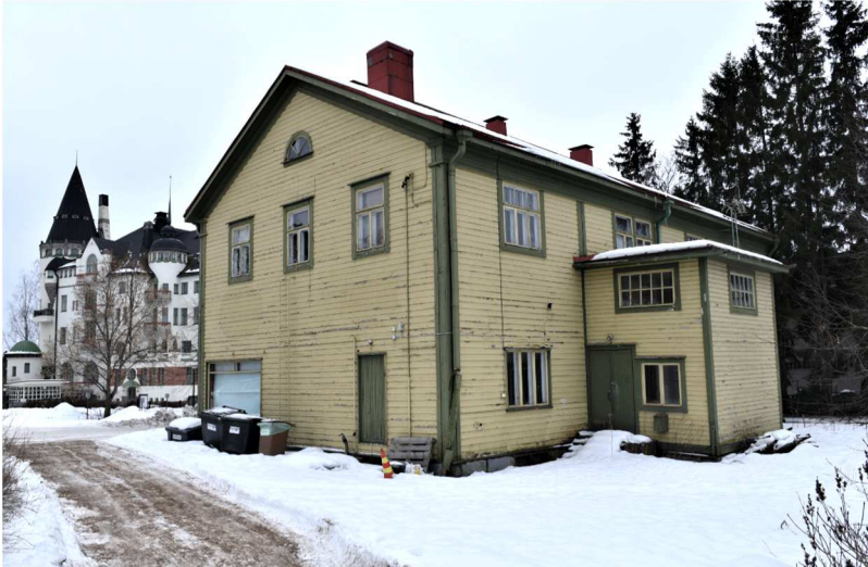
Kuva: Talon takafasadissa porrashuoneen yläpuolella näkyy alkuperäinen pysty jakolista. Talon kaikki ulko-ovet ovat puuvia, joissa kapea makkarapaneelipinta.
