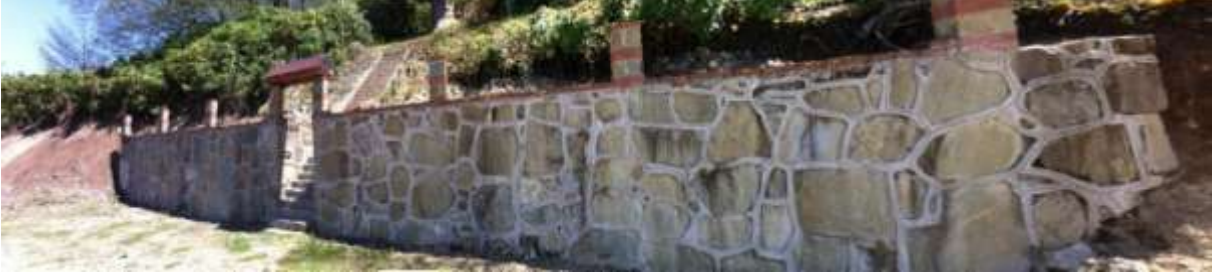
Fotoğraf 26 1665 Yaşındaki Ağacın Altı Kotundaki İstinat Duvarı
