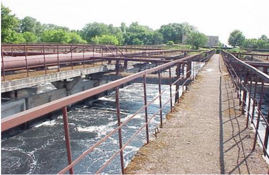
Очисні споруди ЛМКП «Львівводоканал»
