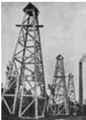
23. Salice: pozzi di petrolio, interno del cantiere.
