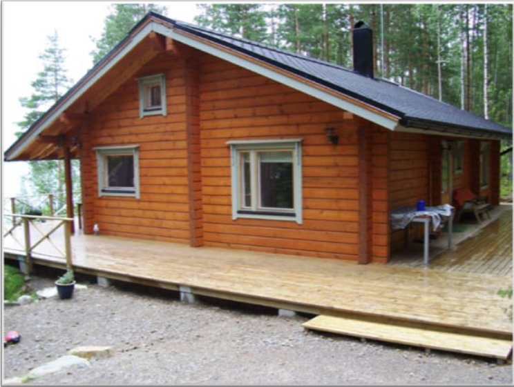
Tuomo Säterin oma rakentama lomayksikkö.
