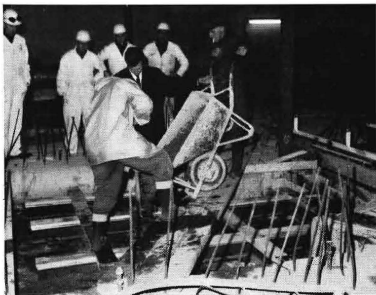
Fig. 6. De montage van ATHENE, foto genomen tijdens het storten van de fundering voor het waterbassin.
