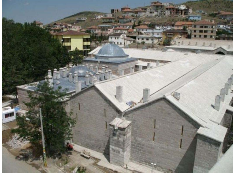
Fotoğraf 4.6: Öküz Mehmet Paşa Kervansarayı'nın Güneyden Görünüşü
