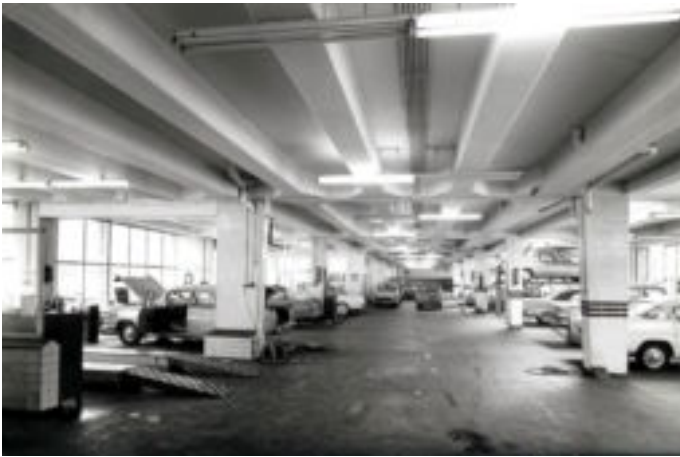
Foto 7. De reparatiewerkplaats op de begane grond aan de 2e Schuytstraat 292-324 in Den Haag.
