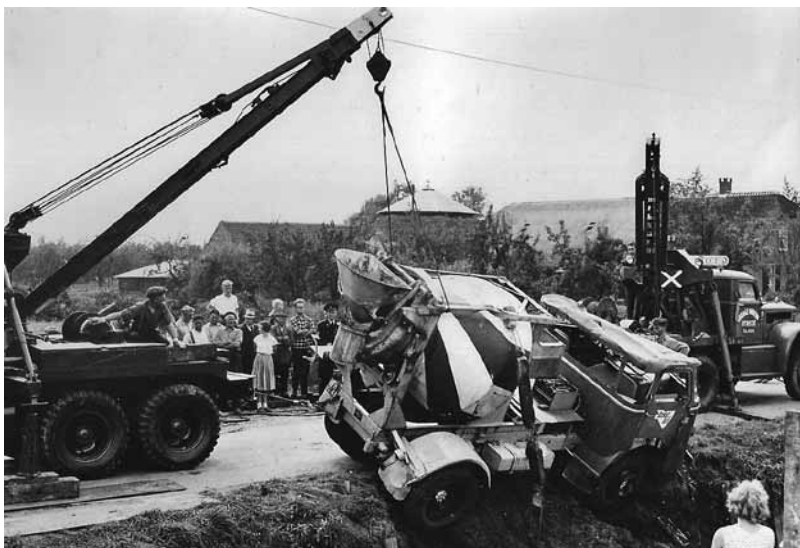
afbeelding 9 De verbouwde Diamond T bergt samen met de Federal 606 een betonwagen die in Groenekan van de weg was geraakt. Bij bergingen als deze bleken de later achter de kranen opgebouwde lieren onmisbaar. Ongeveer 1960.
