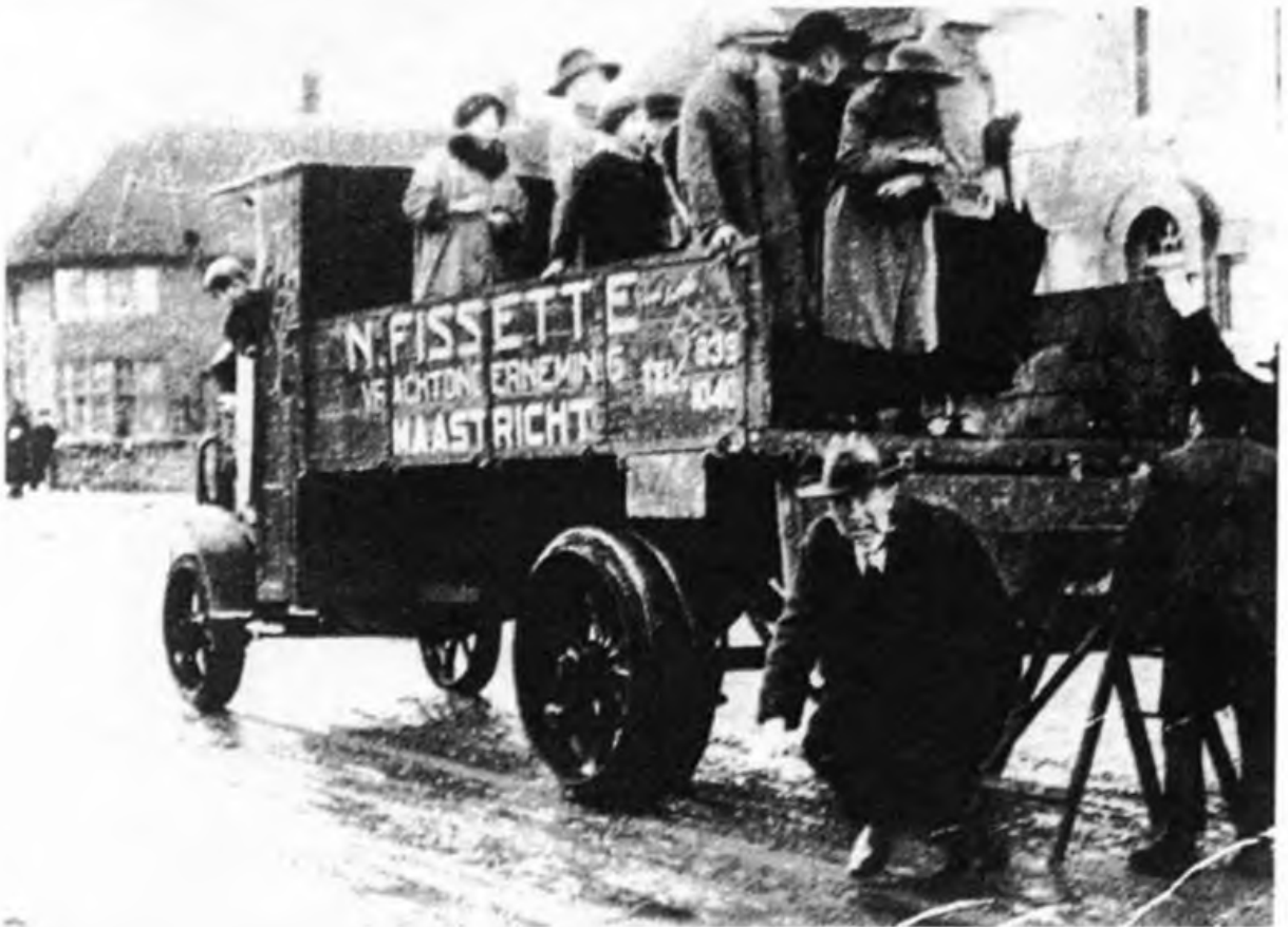
Afb.5 Tijdens een overstroming van de Maas in 1917 werd een vrachtauto (nog met kettingsaandrijving) van Fissette ingezet (collectie: Jac Maurer)
