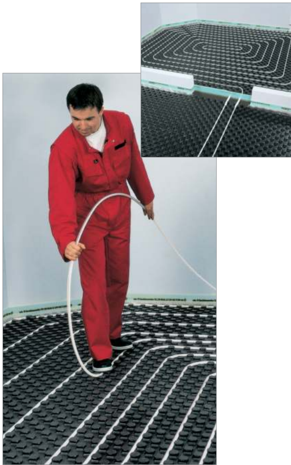
Figura 91. Instalación sencilla de un sistema integrado de calefacción y refrigeración de superficie utilizando el ejemplo de un suelo radiante
