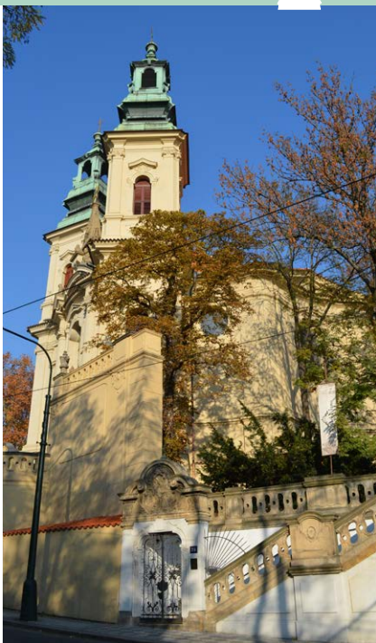
Vstupní branka a schodiště do farní zahrady, vybudované na počátku 20. století
