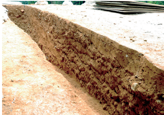
6 前方部頂盛土構築状況（北東から）
