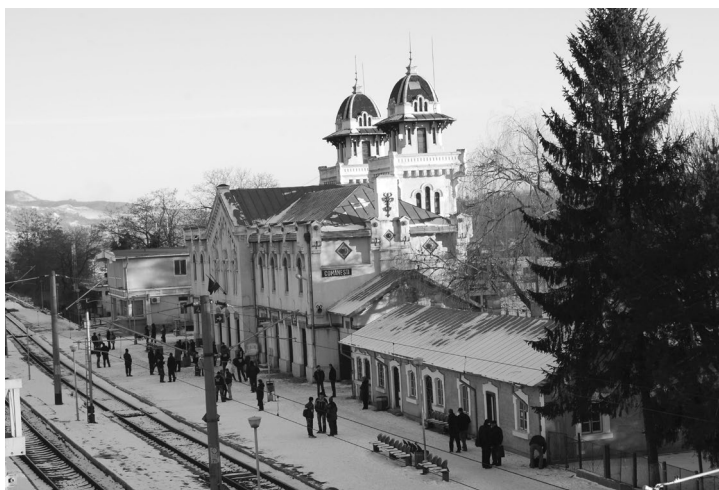
Foto: Stația CFR Comănești
