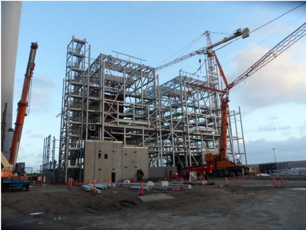
DANSK BETONFORENING, BETONREPARATION OG RENOVERING 2016, 2. FEBRUAR
