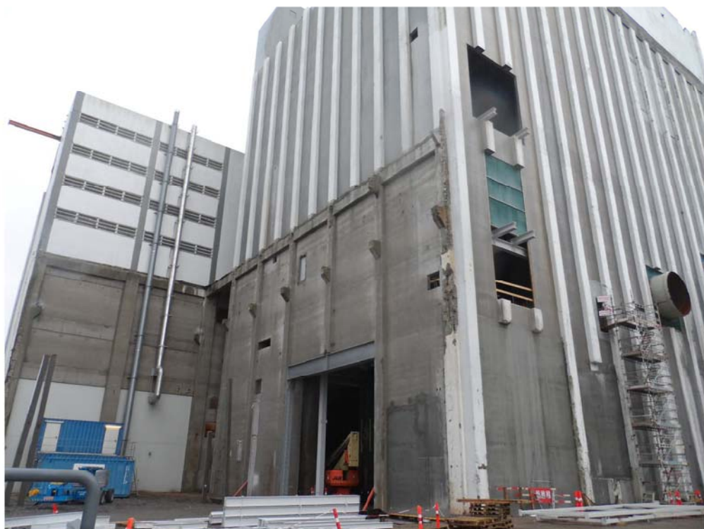
DANSK BETONFORENING, BETONREPARATION OG RENOVERING 2016, 2. FEBRUAR
