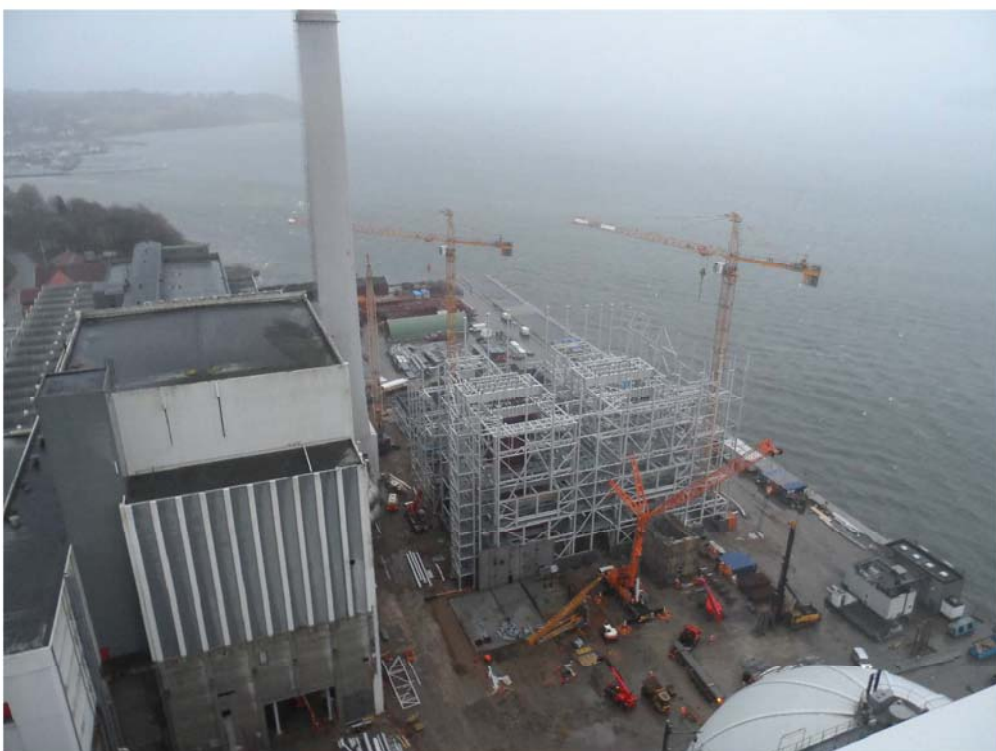
DANSK BETONFORENING, BETONREPARATION OG RENOVERING 2016, 2. FEBRUAR
