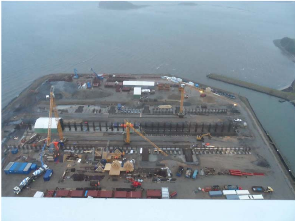
DANSK BETONFORENING, BETONREPARATION OG RENOVERING 2016, 2. FEBRUAR
