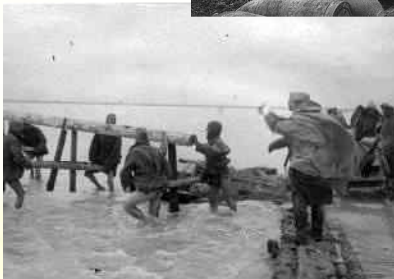
Строительство одного из двух деревянных мостов через Сиваш, ноябрь-декабрь, 1943 г.
