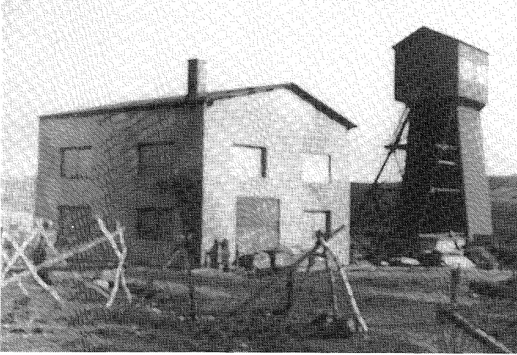
Kaulatunturilta kaivokseen louhitun pystykuilun nosturitorni. Kuilua käytettiin pääasiassa vain kaivoksen eri tasojen välisessä huoltoliikenteessä.
