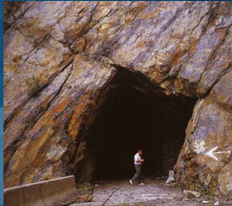
馬陵三號隧道東口之解壓節理
