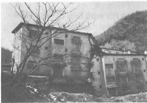
圖 6.122 因斷層(火山性斷層)位移裂成兩半的公寓(有珠山 西山川) 6)
