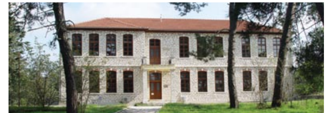
το σημερινό σχολείο κτίστηκε το 1924, πιθανόν από τον αρχιτέκτονα Περικλή Μελίρρυτο, και στεγάζει το Πνευματικό Κέντρο
