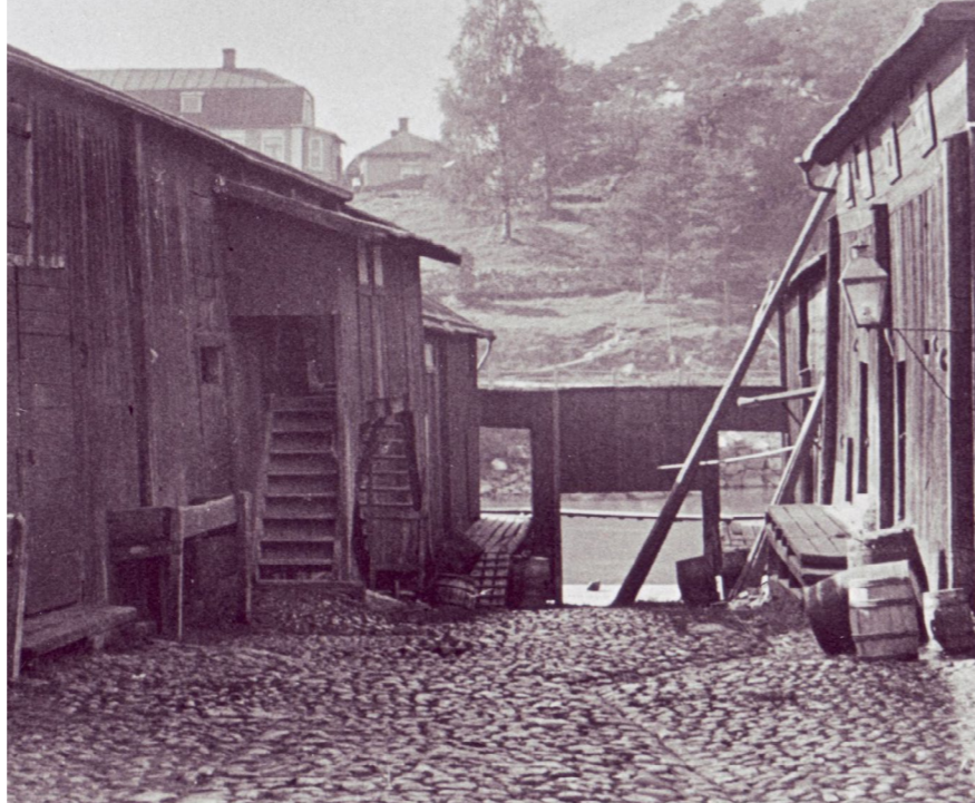
Pihapinnalla sadevesikourut ovat kauniisti mukulakivistä ladottuja. Ne muodostavat kiveyskuviossa hienon jäsenmyksen ja korostavat maaston muotoa. Kiveyksen lomasta on vettä imeytynyt maastoon ja istutusten juuristoalueille. Jokikatu 10 kauppiaapihan kiveyksessä kulkevat sadevesijurit suuntaa vaibtaen, yläpiballa vinosti poikittain ja alapiballa rakennusten suuntaisesti. Pihan valaisimet oli kiinnitetty rakennusten seiiniin. Katolta kerättiin sadevesi kesäaikana tynnyreihin. (Porvoon museo)
