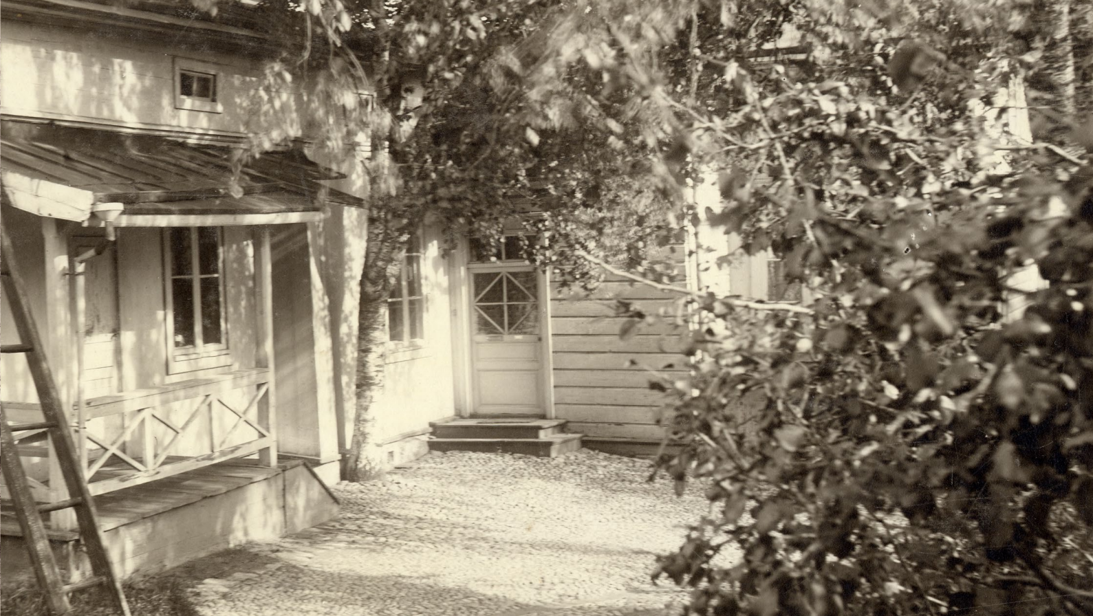
Kaartuva sorapintainen ajokäytävä johtaa sivurakennuksille. Sisäänkäyntien edustat ja seinustat ovat mallikelpoisesti kivettyjä. Nuori koivu ei kuulu seinustalle. (Porvoon museo)
